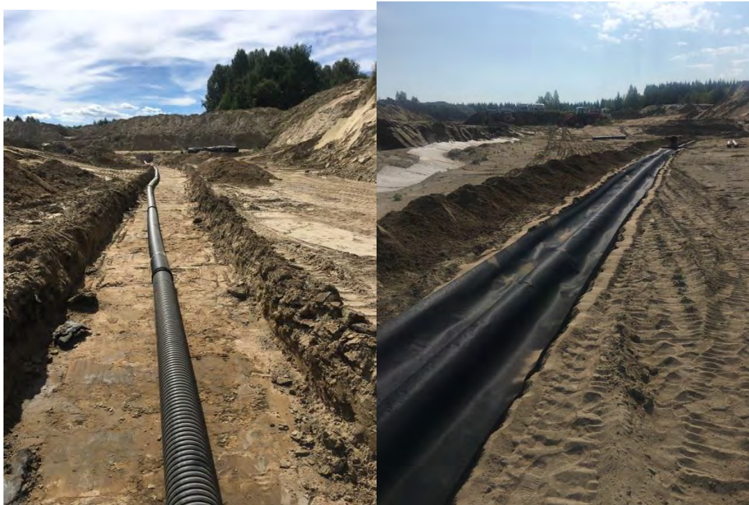
Figur 9. Nedlegging av permeable drensrør i bunnen av deponicelle 1. Røret er dekket med membran for å hindre tilslamming (foto: Herstua Miljø AS).
