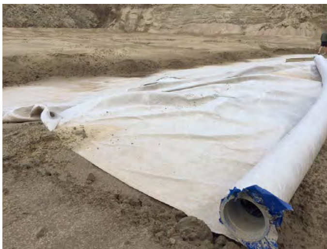
Figur 4. Bildet viser bentonittduken som er lagt under 50 cm med sand (foto: Sweco Norge AS).
