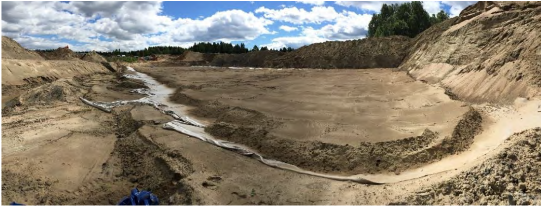
Figur 2. Bilde av deponicelle 1 med bentonittduken som er dekket med 50 cm sand. Bildet er tatt fra rensedam 1 og nordover mot deponicellen (foto: Sweco).
