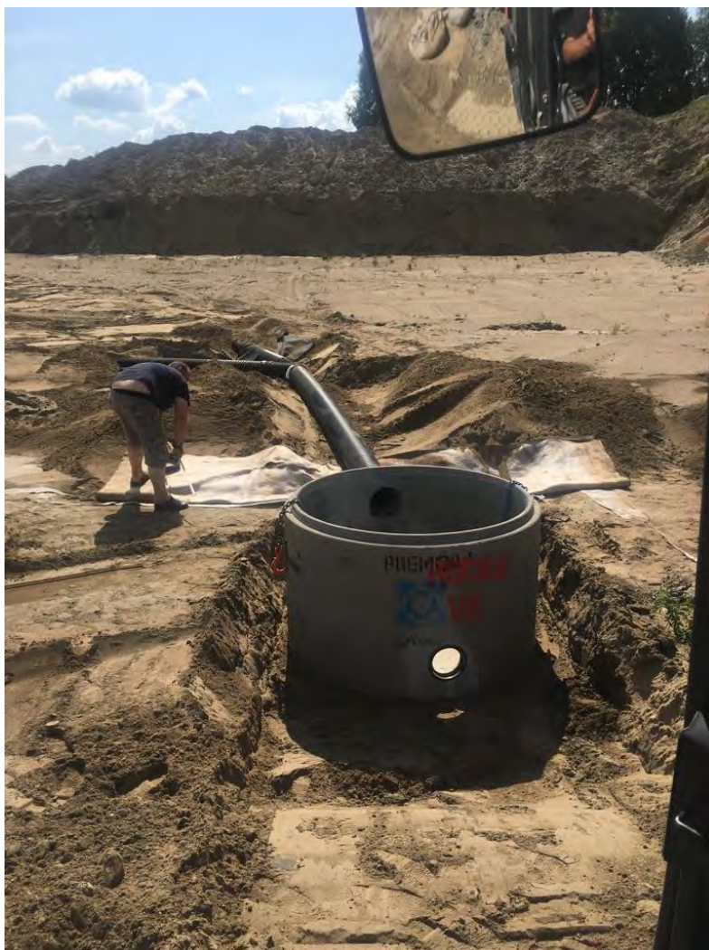
Figur 10. Nedsetting av kum 1 og kobling med drensledning fra deponicelle 1.
