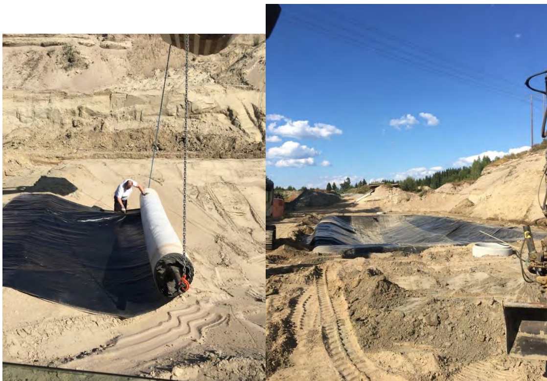
Figur 6. Legging av membran i sedimentasjonsbasseng (foto: Herstua Miljø AS)
