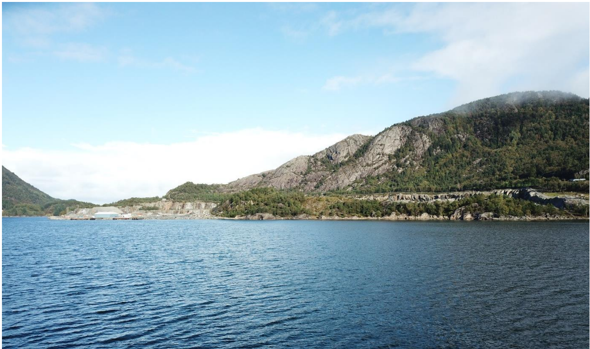
Figur 8.8: Dagens situasjon sett fra en annen vinkel på sjøen. Det gjenstående uttaksområdet dekker store deler av bruddveggen sett fra denne vinkelen. Bilde tatt 24.09.2018.
