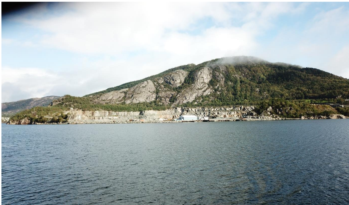
Figur 8.6: Dagens situasjon sett fra sjøen. Det gjenstående uttaksområdet til høyre i bildet dekker en del av bruddet. Bilde tatt 24.09.2018.
