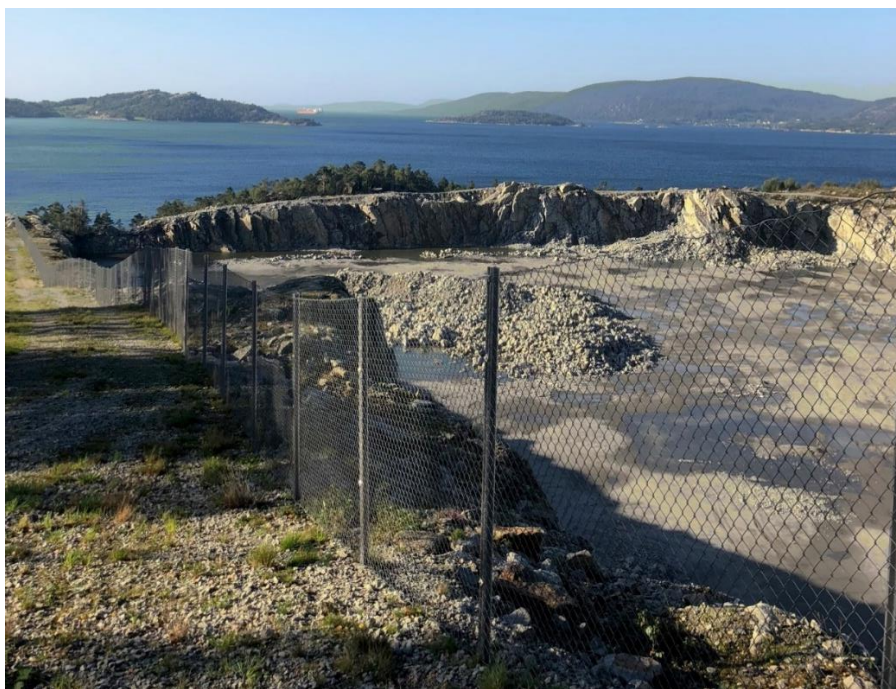
Figur 8.1: Bruddkanten er sikret med 2 meter høyt permanent gjerde. Foto tatt 18.09.2018.
