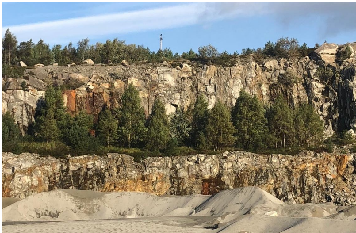
Figur 8.5: Det har grodd til en del vegetasjon på pallehyllene nordvest i bruddet. Bilde tatt 18.09.2018.
