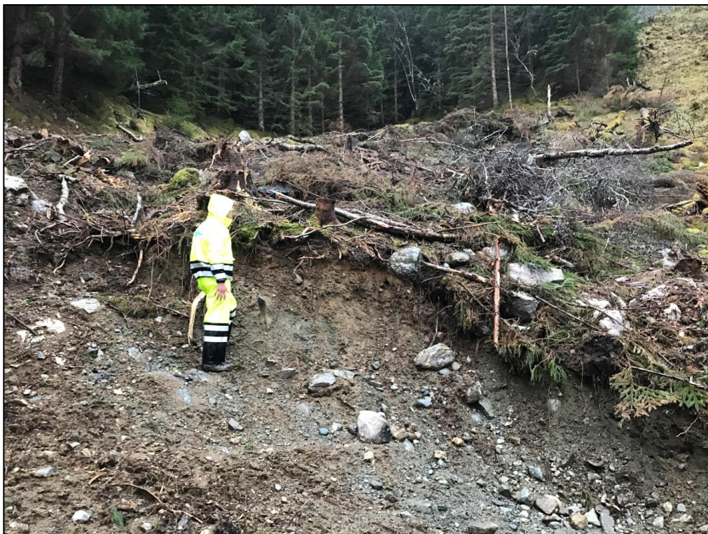
Figur 22: Det ble observert mye løsmasser langs skogsvegen under høyspentledningen.
