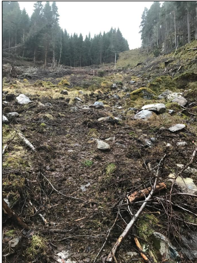
Figur 23: Bildet viser masser som ser ut som at har blitt avsatt i forbindelse med en tidligere masseforflytning med mye vann. Bildet er tatt på ved skogsvegen i søkket over anleggsvegen. Det ble ikke observert nylig avsatte masser på nedsiden av anleggsvegen.
