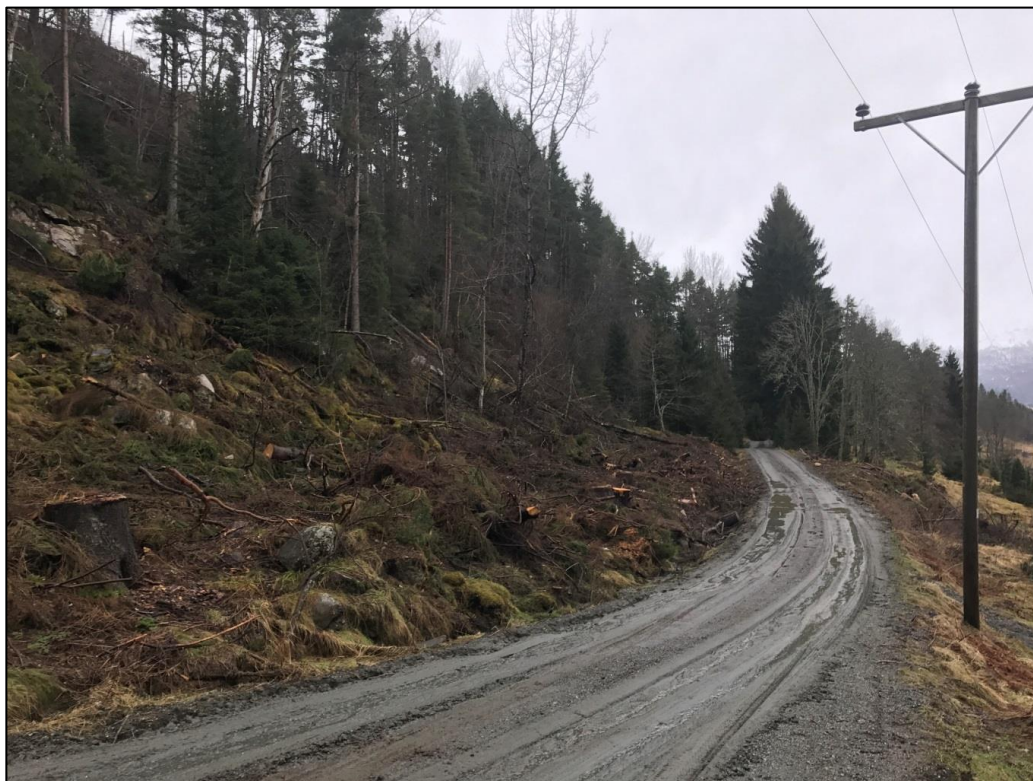
Figur 25: Bildet viser skråning sørvest for anleggsvegen mellom eksisterende industriområde og deponiområdet i nordøst.
