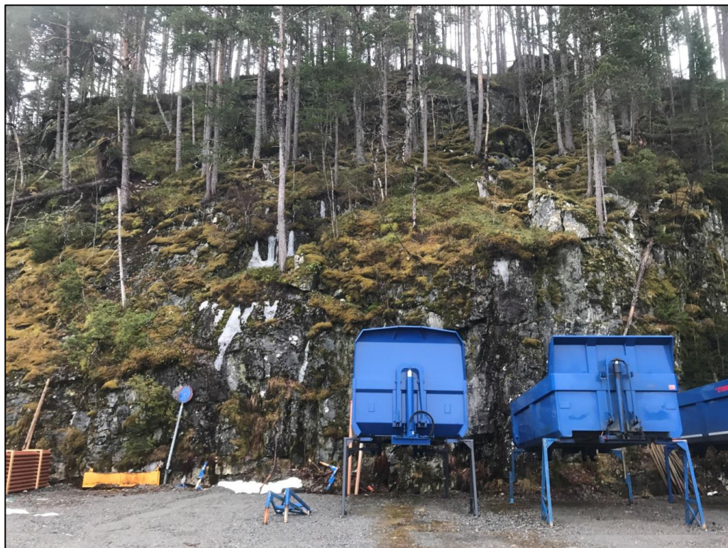
Figur 26: Bildet tatt fra det mindre lagerområdet på østsiden av anleggsvegen. På plakartet er området vist med arealformål «område til industriformål» (I2). Over lagerområdet er det en bratt skråning. I skråningen ligger det avløste blokker og det er lokale berghammere.
