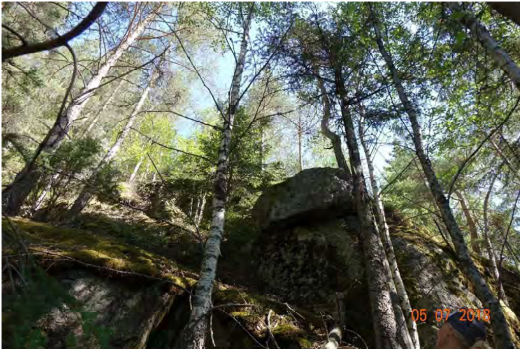
Figur 11 Avløyst blokk i nedre del av fjellsyggen rett bak plangrensa.
