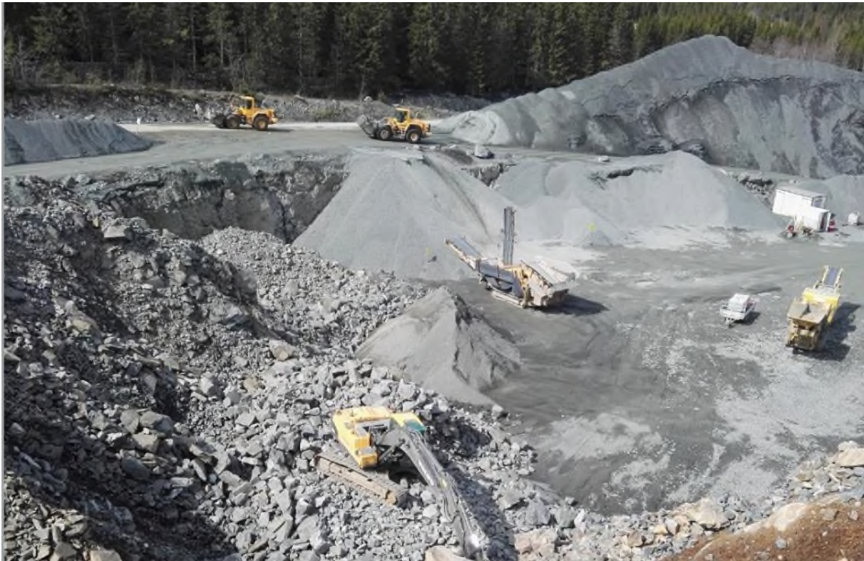
Figur 7. Bilde fra Syljulibakken tatt fra øst mot vest og Åsvegen i mai 2018. Kilde Norconsult AS.
