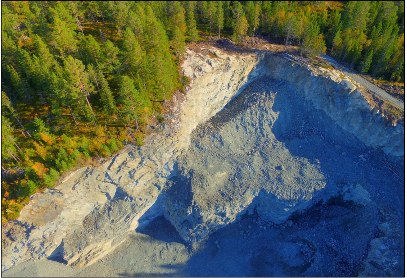
Figur 1 Bruddkanten sett ovenfra. Dronebilde tatt av Pro Invenia 21.09.17
