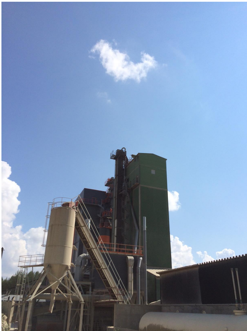
Figur 7 Sandtørke og siloanlegg til produksjon av finfraksjoner til mørteltilslag
