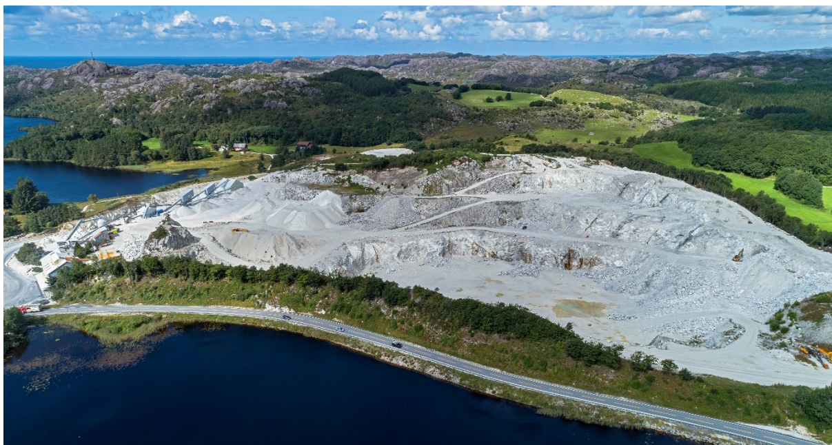
Bilde 2 - Oversikt over bruddet ved Rudlå
