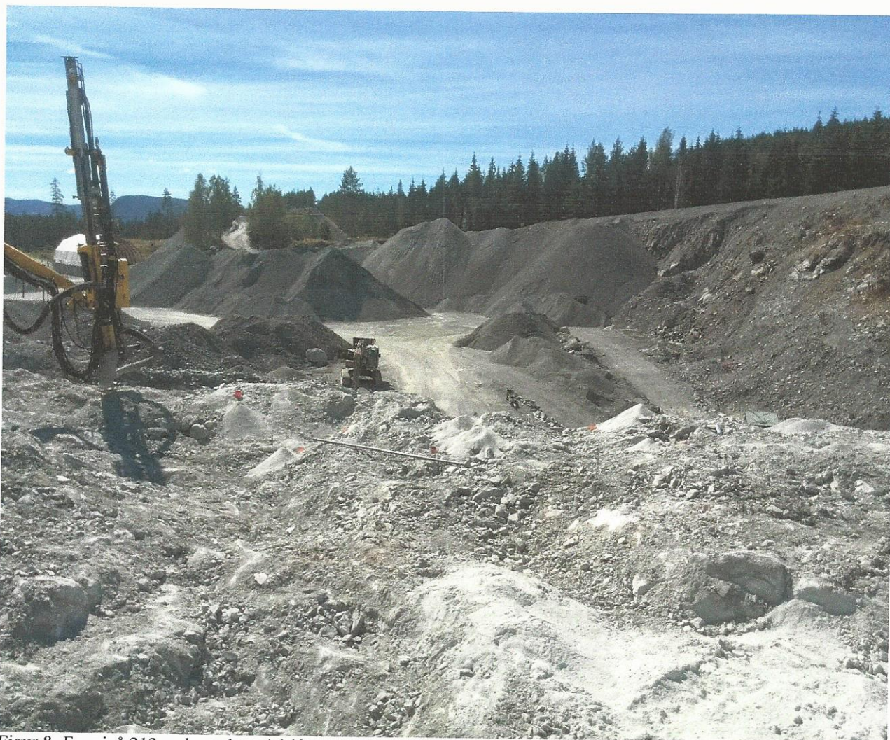
Figur 8- Fra nivå 213 ned mot lager/ driftsområdet
