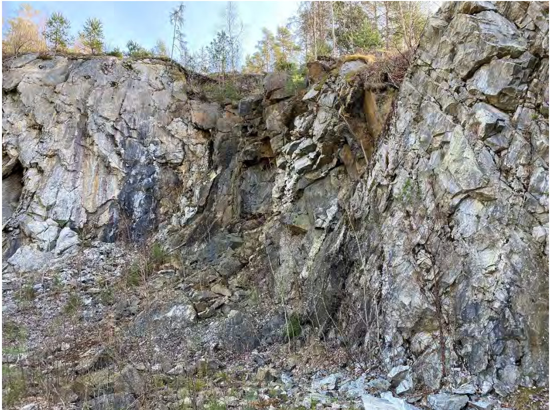
Bildet er tatt fra driftsflata mot øst og viser bruddveggen som skal palles ned og renskes for blokk.
