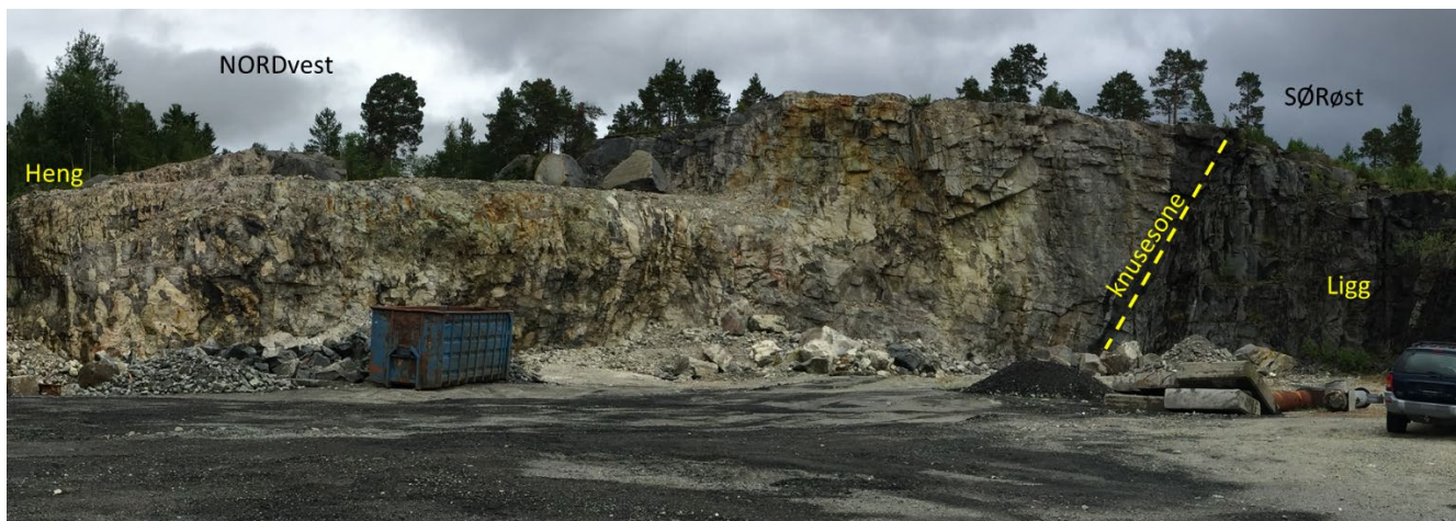
Figur 2 Foto av brudd 2022 sett mot nordøst.
