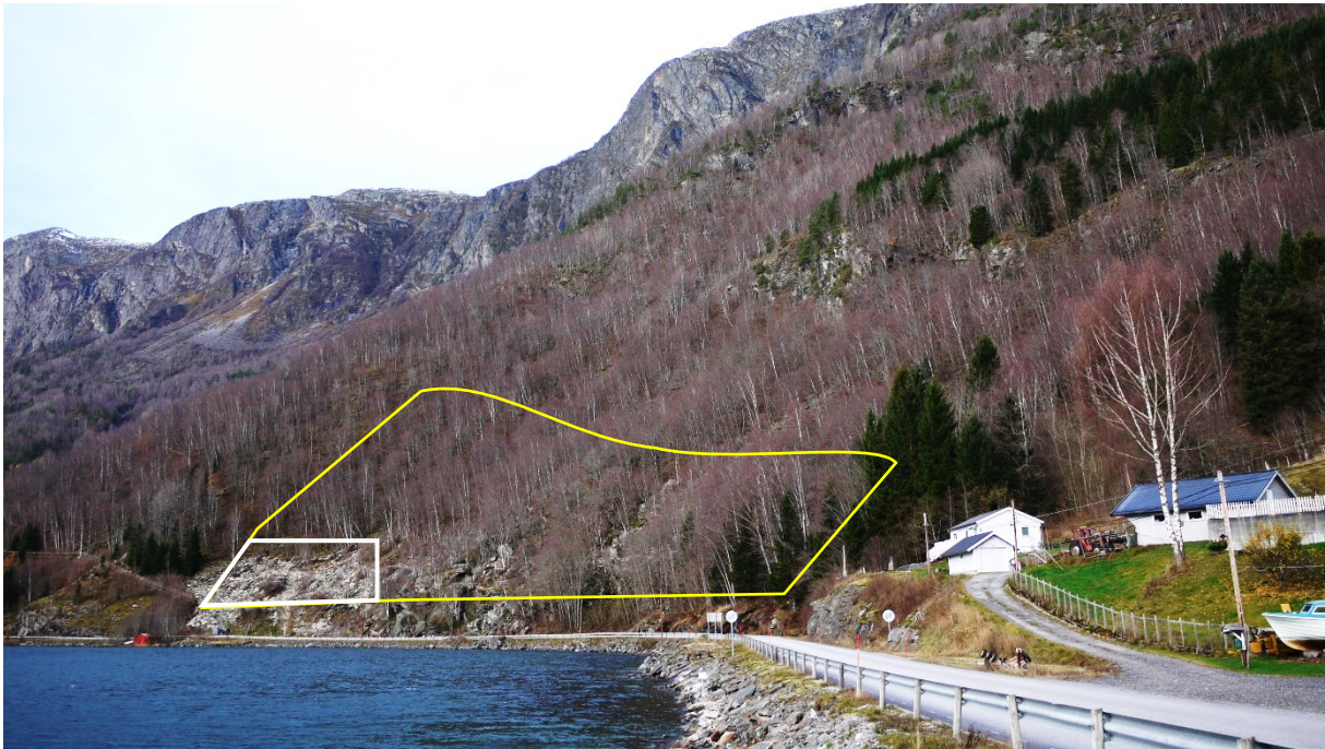
Fig. 3. Planlagt uttak sett fra Fv. 55. Fra området i vest, markert med hvitt omriss, er det alt tatt ut masser. Terrenginngrepet i forbindelse med planlagt uttak vil bli tilsvarende.
