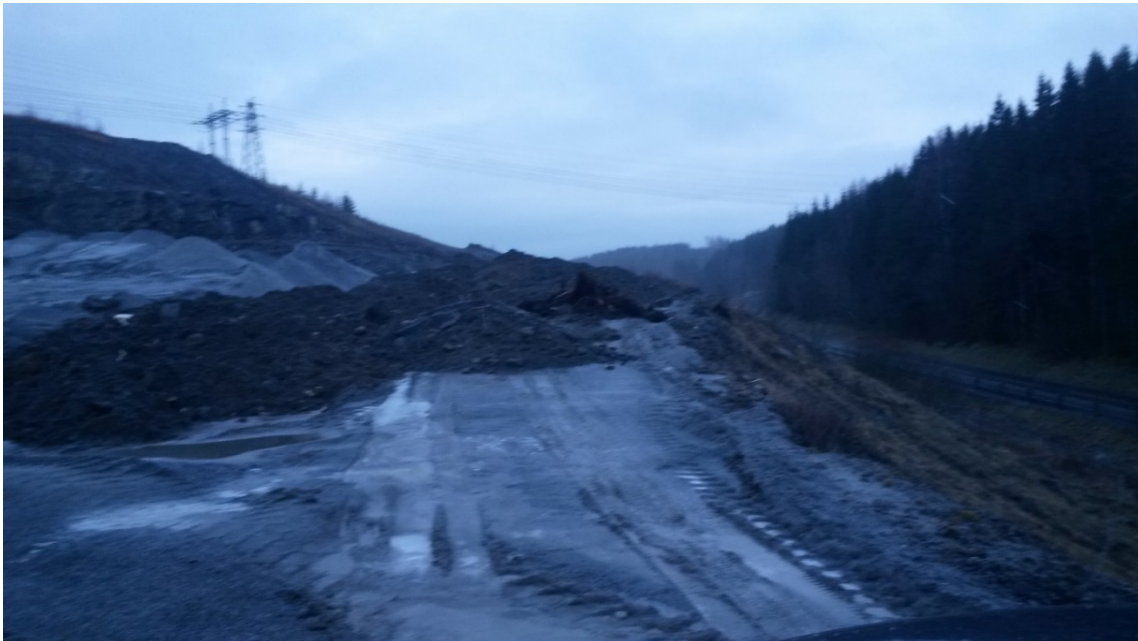
Figur 5. Overdekning lagt til side for senere bruk.
