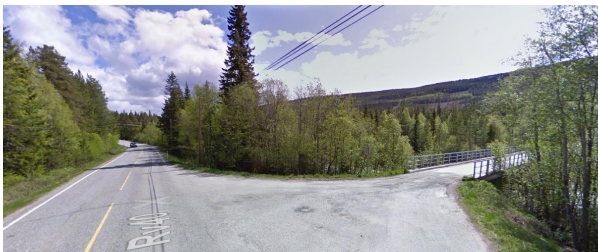
Figur 31. Bildet viser eksisterende kryss i retningen østover mot Uvdal sentrum (Google Street view).
