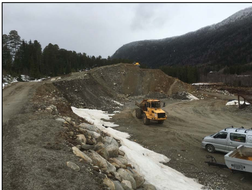
Bilde 7. Bildet er tatt mot vest i etappe 1. Vegen som danner bunnivået ses til høyre i bildet. Det tas masser ut i dette område på nåværende tidspunkt. Legg merke til blandingen mellom sand, grus og større steiner.
