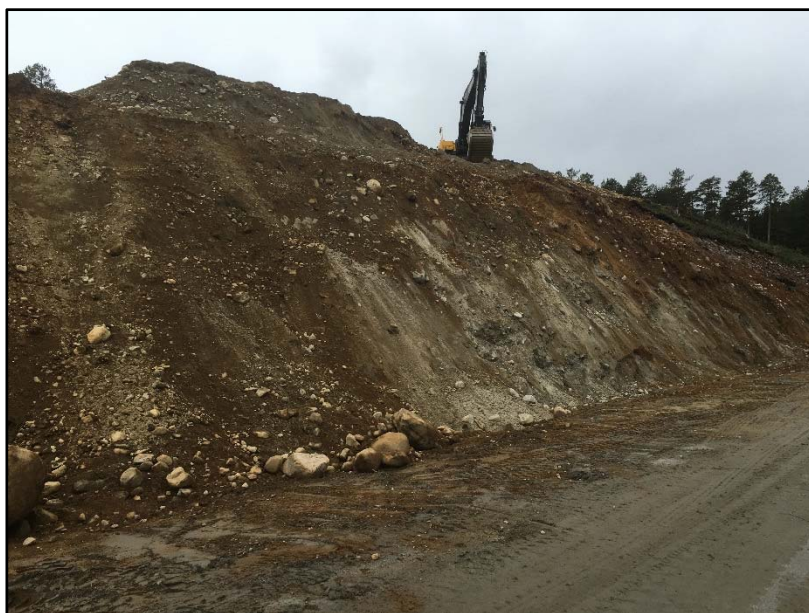
Bilde 8. Bilde tatt fra vegen langs nordsiden av område 1 og mot sørvest inn i området.
