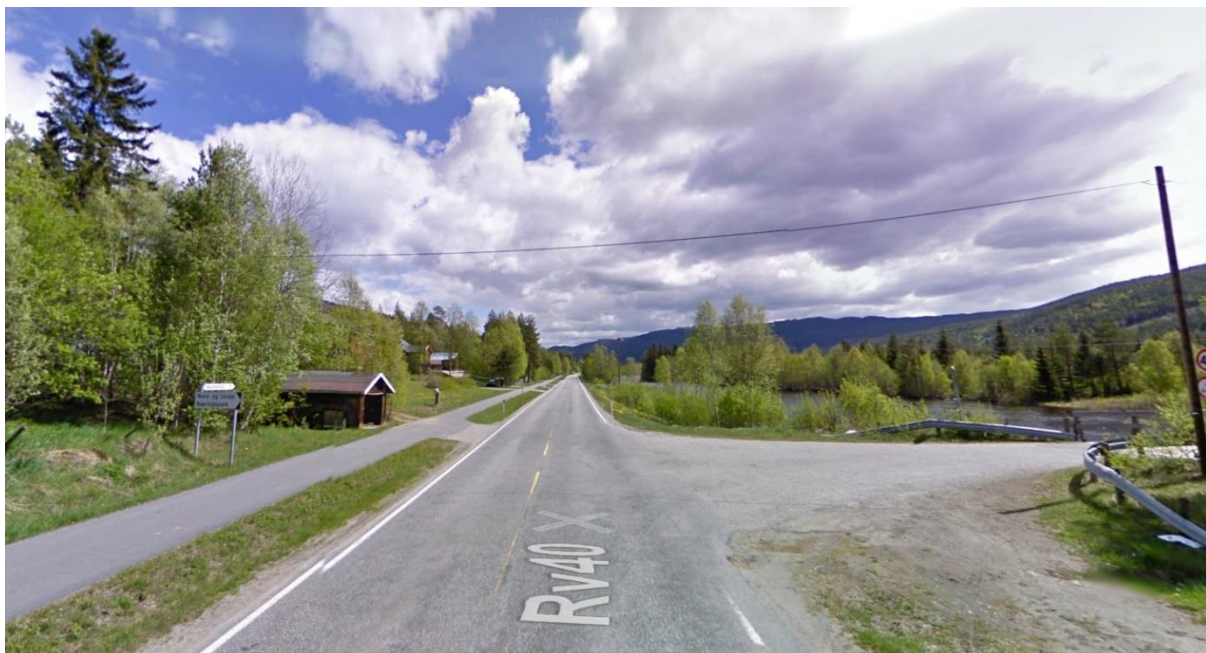
Figur 36. Bildet viser eksisterende kryss B i retningen østover mot Rødberg (Google Street view).
