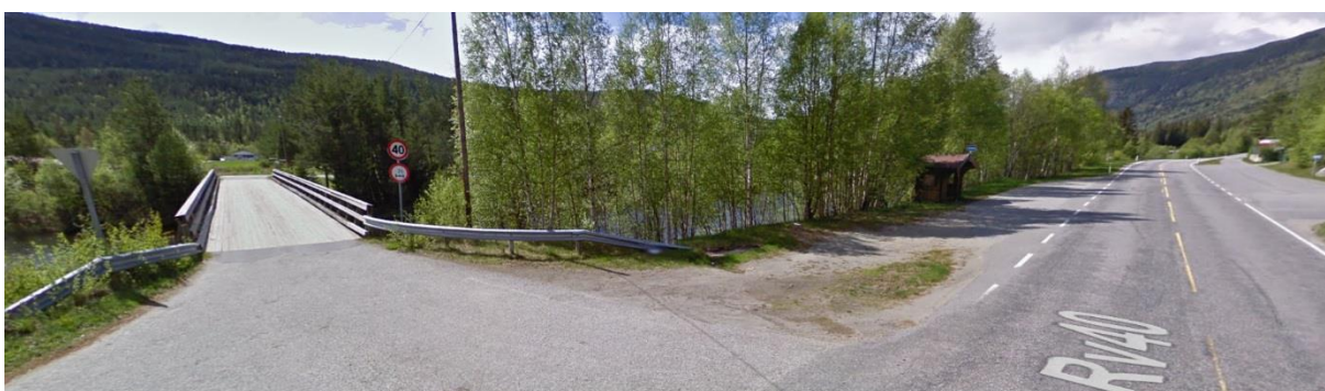
Figur 35. Bildet viser eksisterende kryss B i retningen vestover mot Uvdal sentrum (Google Street view).
