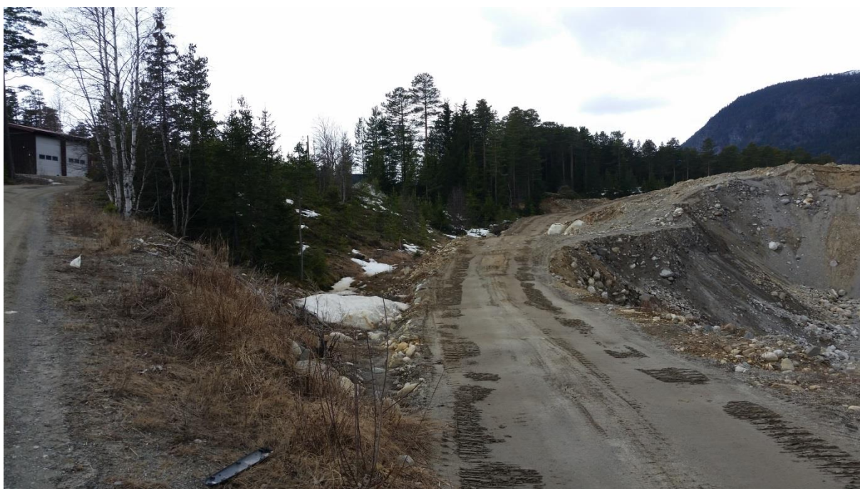
Figur 6. Interne veger på området. Vegen til venstre betjener gjenvinningsanlegg, mens anleggsvegen til høyre brukes for delområde A (se plankart).
