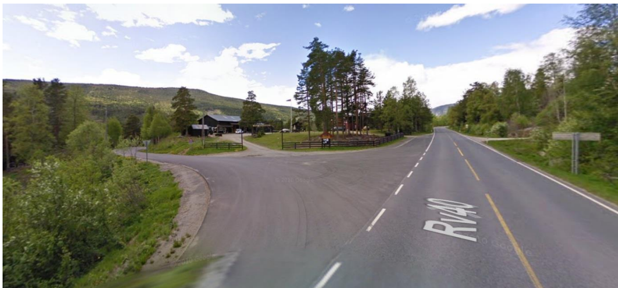
Figur 38. Bildet viser eksisterende kryss B i retningen vestover mot Uvdal sentrum (Google Street view).
