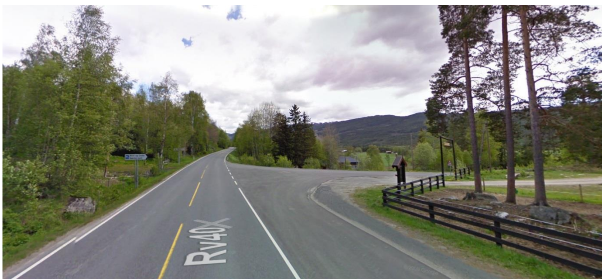
Figur 39. Bildet viser eksisterende kryss B i retningen østover mot Rødberg (Google Street view).
