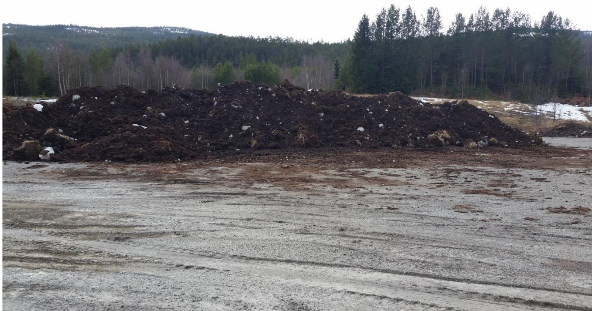
Figur 25. Humusrike toppmasser er tatt vare på og kan brukes til naturlig revegetering.
