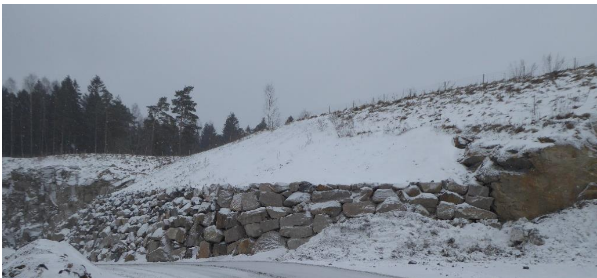
Foto 16. Langs veien ned til bruddet er det et område som er forbygget med tørrsteinsmur og fyllmasser i bakkant. Den opprinnelige bruddkanten raste ut i 2015 i forbindelse med sprengning nede i pukkverket. Muligens kan sonen med amfibolitt ha representert en svakhetssone som kombinert med vertikale sprekker, være årsaken til at dette området raste ut.
