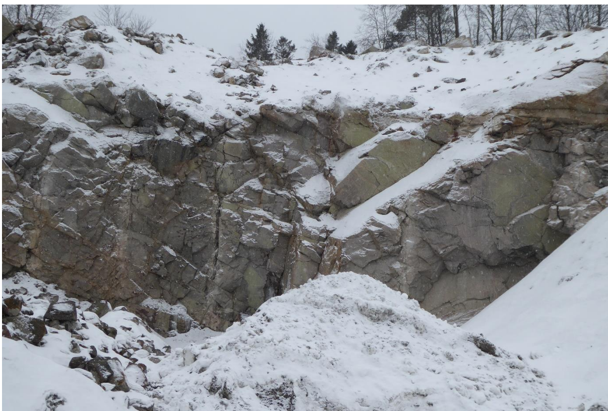
Foto 9. Lengst syd i bruddet. Flere parallelle vertikale sprekker med strøk tilnærmet N330 og et annet sprekkesystem med strøk N20 og fall 30 mot Ø. (Kom ikke helt inntil lokaliteten grunnet sprengsteins masser i forkant.)
