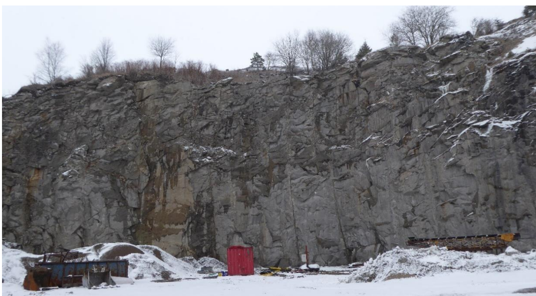
Foto 5. Bruddveggen mot nord i den eldste delen av pukkverket, med grunnvannspumpen ved rød container. Øvre del av veggens er relativt meget oppsprukket med sprekker og benker påvirket av terrengoverflaten. Nedre del er mer massiv med få markerte sprekker.
