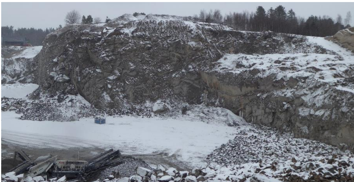
Foto 10. Foto av området nord i den østre del av bruddet. Til høyre i bildet er pallnivå kote +35 (Se figur 5). Midt på fotografiet er det et relativt oppsprukket parti med mange nye sprekker som følge av kraftig sprengning for masseuttak med flere løse blokker.
