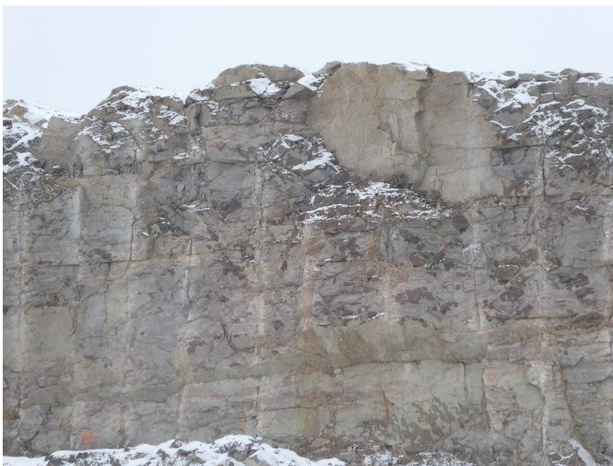
Foto 12. Detalj foto av pallveggen vist på figur 5.
