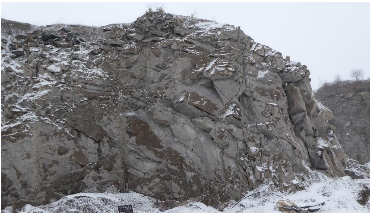
Foto 8. Rundt hjørnet på foto 7. Her er de samme sprekkeretningene med fall 20 grader mot øst. I tillegg er det flere nesten vertikale sprekker med strøk N35 og fall 85 mot Ø.
