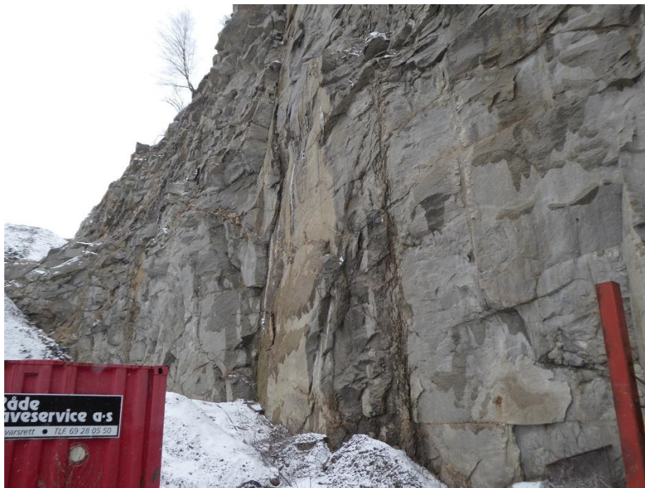
Foto 6. Detalj av en tilnærmet vertikal «gammel» sprekk (med rustutfelling). Denne sprekken går helt opp til toppen av veggen. (Se foto 5.). Sprekken har strøk N325 og er tilnærmet vertikal.
