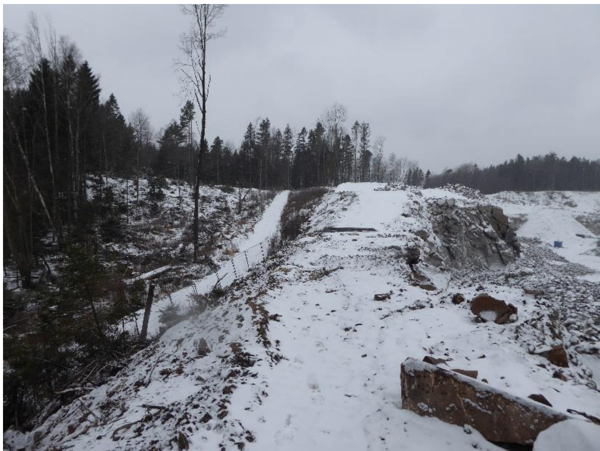
Foto 14. Dette er gjenstående kant mellom området som ble sprengt i januar 2018 og skogsveien som grenser mot naturvernområdet. (Sett mot SV).
