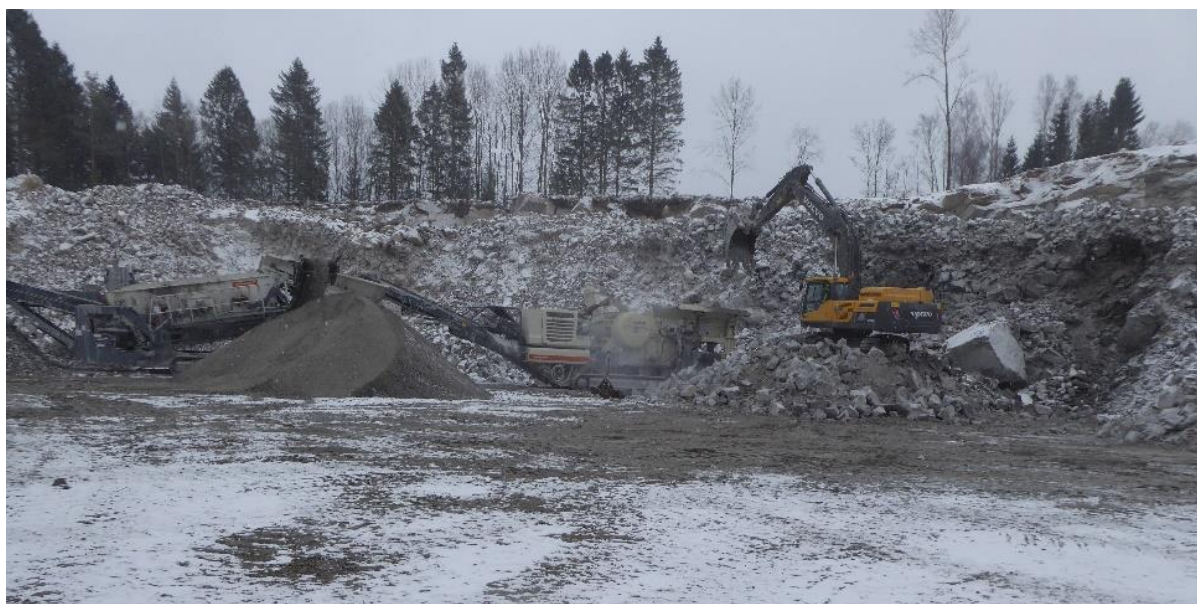
Foto 13. Lengst NØ i pukkverket ble det i januar 2018 sprengt ut to seksjoner. Dette er helt i ytterkant av pukkverket mot naturvernområdet, se figur 4. Her ligger fortsatt de utsprengte massene i røys, slik at bruddkanten ikke kunne inspiseres. Foto 14 er tatt oppe på kanten bak gravemaskinen.
