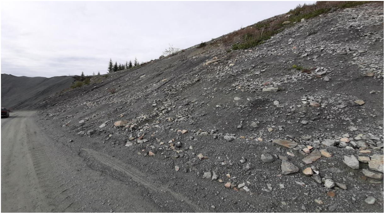
Figur 5 Vrakmasser brukt til reetablering av skråninger
