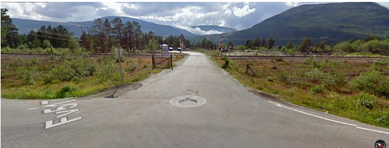
Figur 6. Avkjørsel fra E136 på Fv. 517 Rånåvegen. Jernbaneovergangen ses i bakgrunnen.
