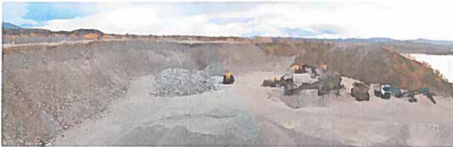
Tjeldgrunnen massetak, øvre nivå.
