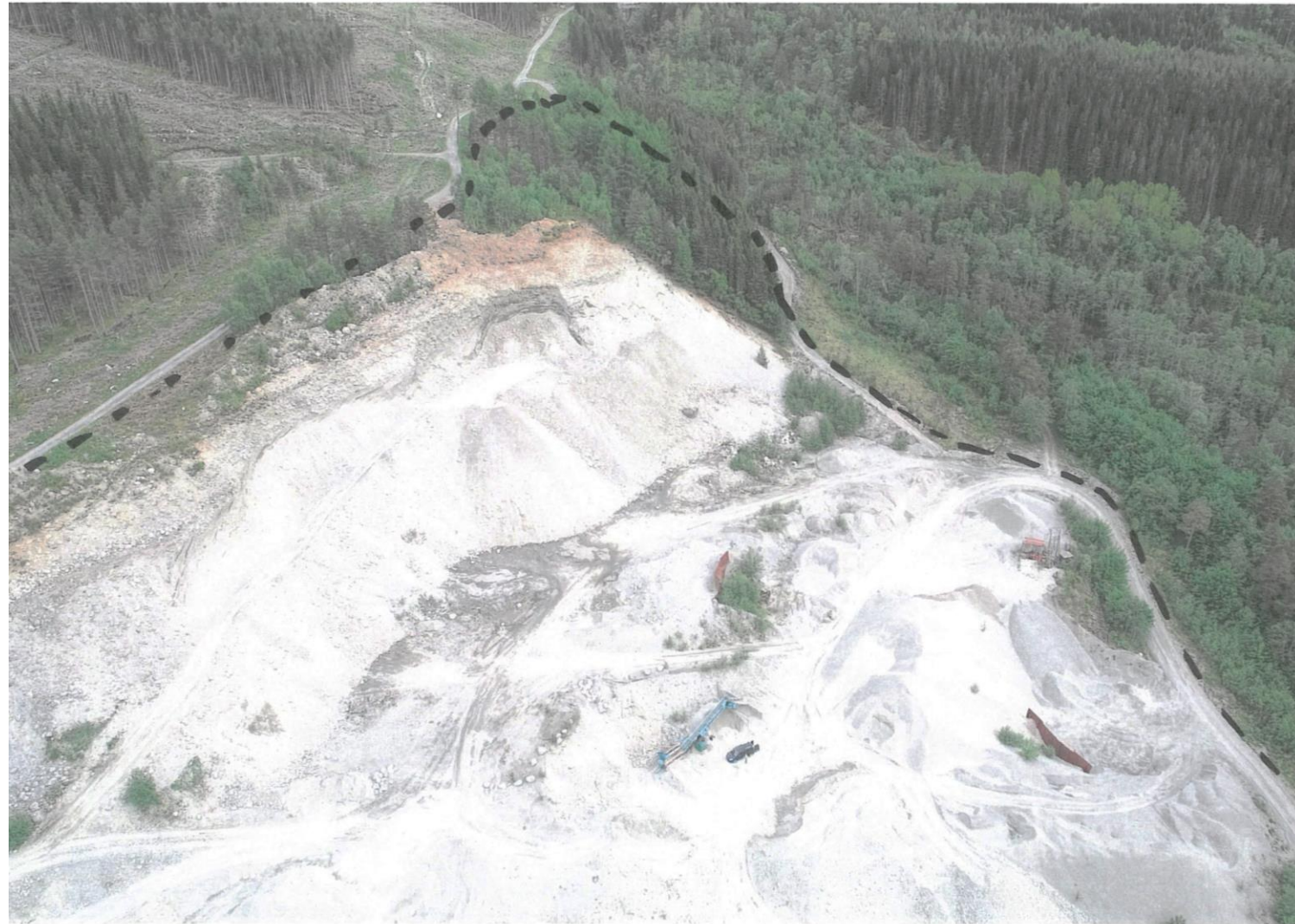
Bilde 2: Bilde tatt med drone. Viser dagens situasjon for fase 3 sør i grustaket som enda ikke er påbegynt. Grustaket er i hovedsak etablert i to hovedplan plan og ett mellomplan. Dette framkommer av vedlagte profiler. Bildet viser plan 2 midt i bildet på ca kote 105.
