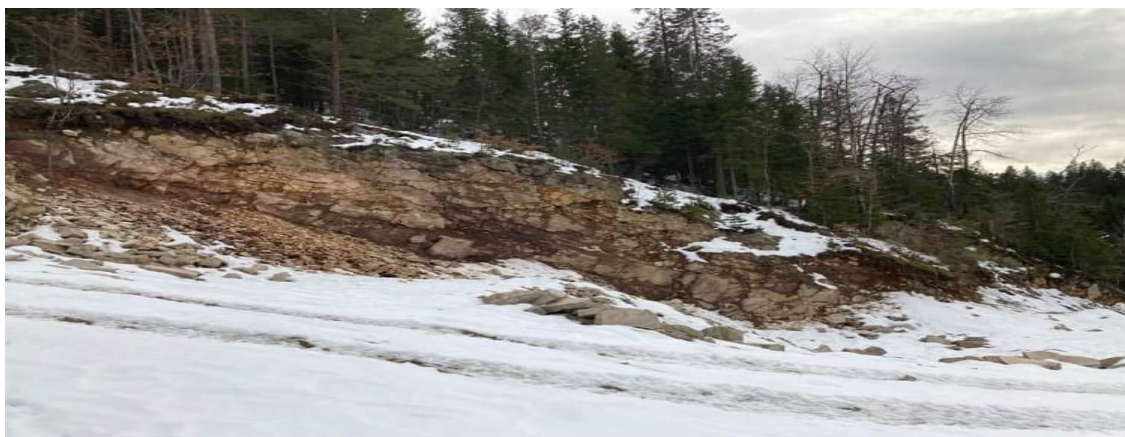
Bilde viser eksisterende uttak
