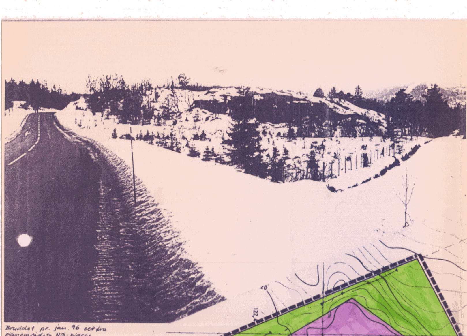
Bruddet pr. jan. 96 sett fra planområdet NB - Nørre Fig. 1 NÆRVÆKNING
