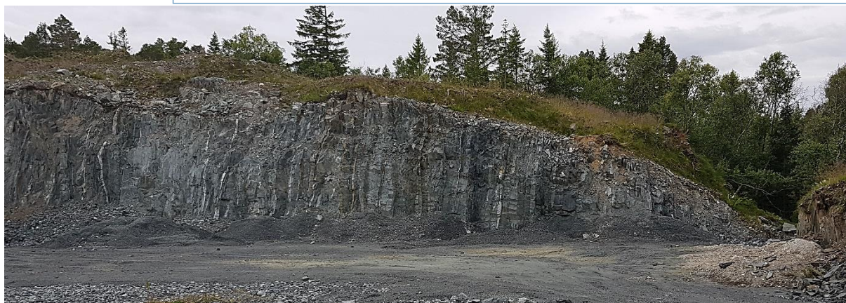
Fig.6: Bruddvegg mot SV viser lagdeling i berg
