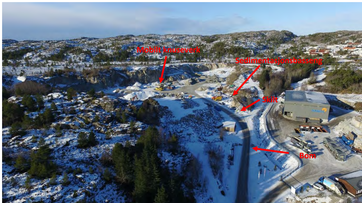
Figur 6-1: Dagens situasjon (februar 2018). Bildet er tatt fra innkjørselen i sørøst mot nordvest.
