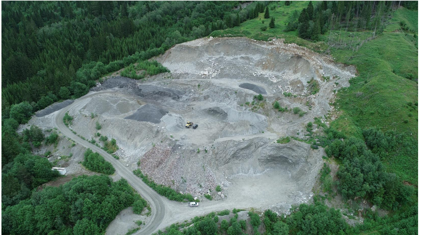
Figur 23. Breihjellen sandtak, oversiktsbilde av dagens situasjon
