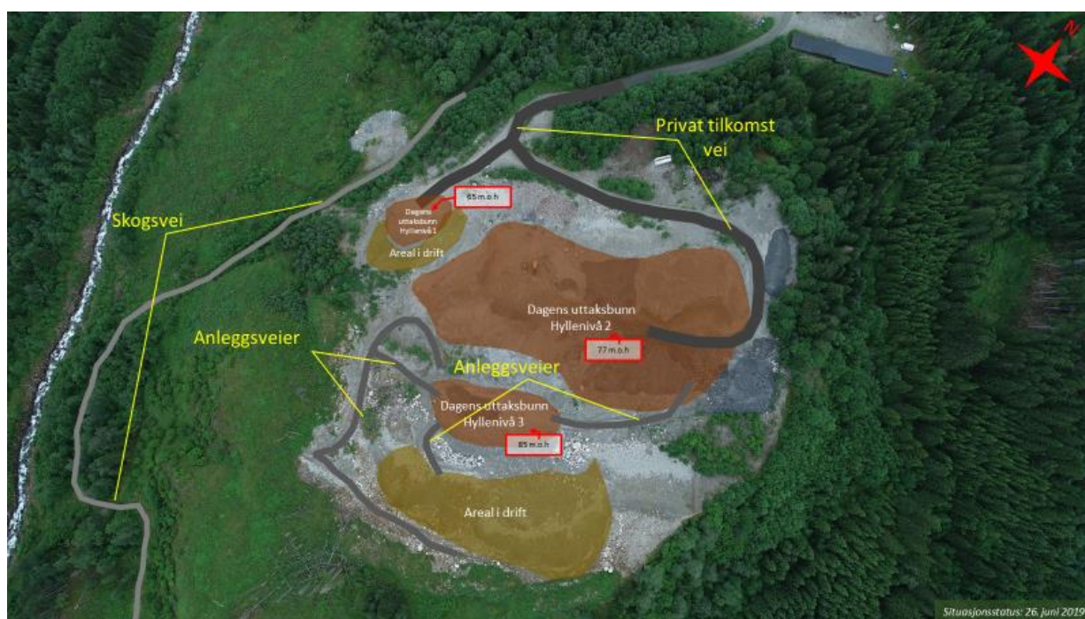
Figur 11. Dagens situasjon ved Breihjellen sandtak med synliggjøring av arealbruk og veier.
