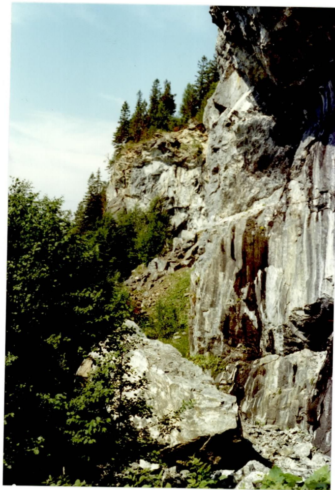
HOLAN KALKBRUDD I980. Bilde av vest-partiet. Farlig overheng.
