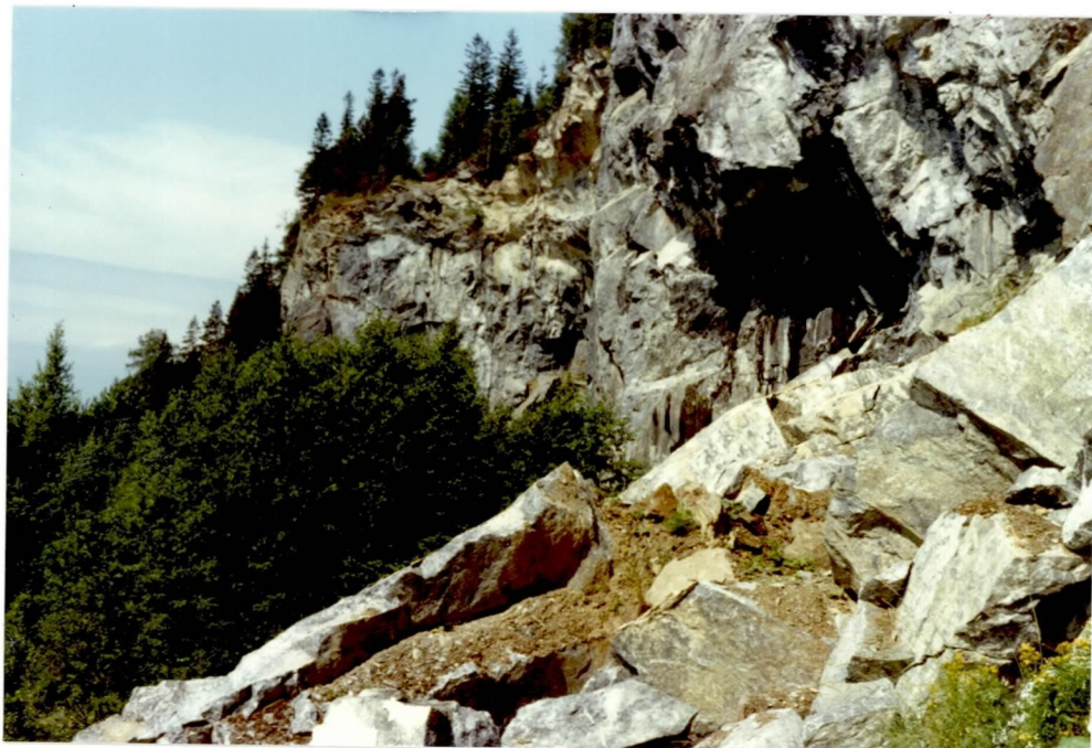
HOLAN KALKBRUDD I980. Bilde av vest-partiet med store nedraste blokker i forgrunnen..
