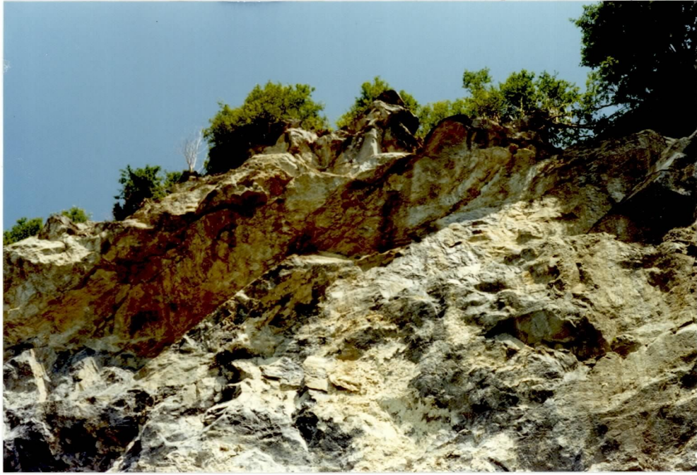
HOLAN KALKBRUDD 1980. Bilde fra midt-partiet. Farlige sprekker i hengen.
