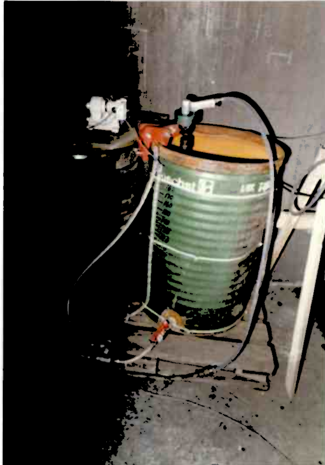
Fig. 3.5 Fat for polymeropløsning og doseringspumpe.
