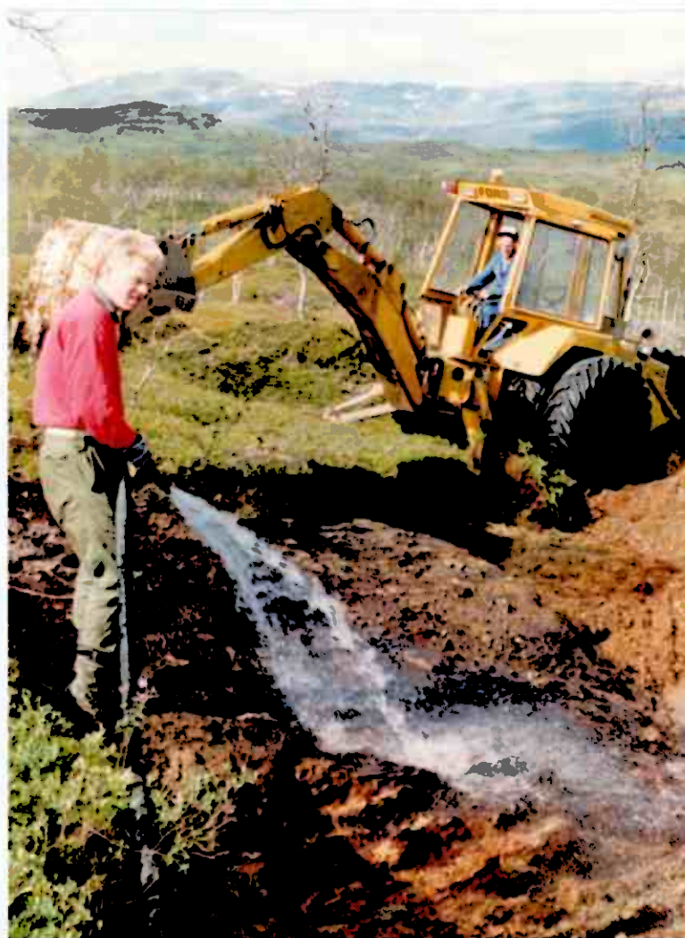
Fig 1. Stripping og spyling på røskepunkt nr 6, Sjapmølia
