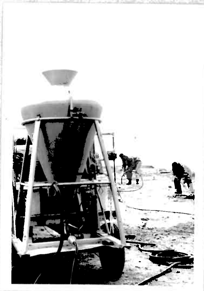
Bildet viser ladeapparatet. I bakgrunnen en mann lader og en mann fyller igjen et hull med borkake.
