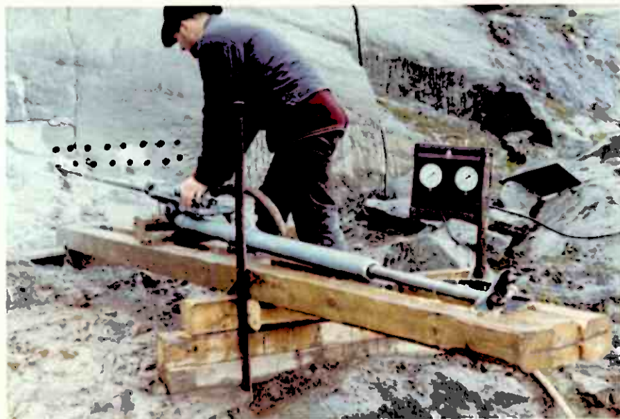
Oppstilling ved sterkt skrående terreng.
