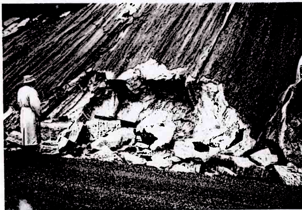
Fig. 4 Fra påhugg ved hovedvei syd for Stuff nr. 1. Fig. viser hvorledes berggrunnen spalter etter foliasjonsplanet.
