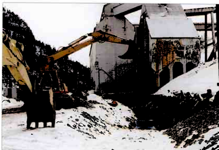
Under: Groften er 7 m dyp og tre rør legges, et større transportrør og to mindre drenerør.
