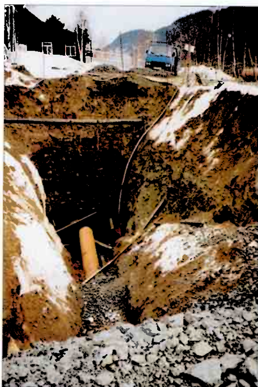
Over: Ved pumpestasjon graves ned til 10 m og fundament for stasjon stopes.
