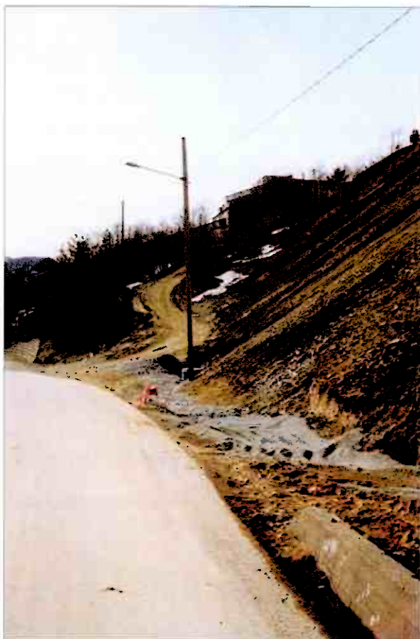
Drensgroften ved foten av nordre herghald samler surt vann som ledes direkte til gammelgruva.
