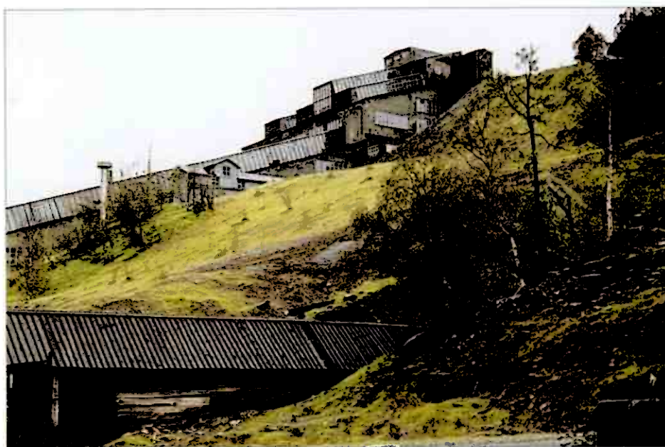
Bilde fra 1971. Tildekking med morene, såing av grasfrø og planting av bjørk.
