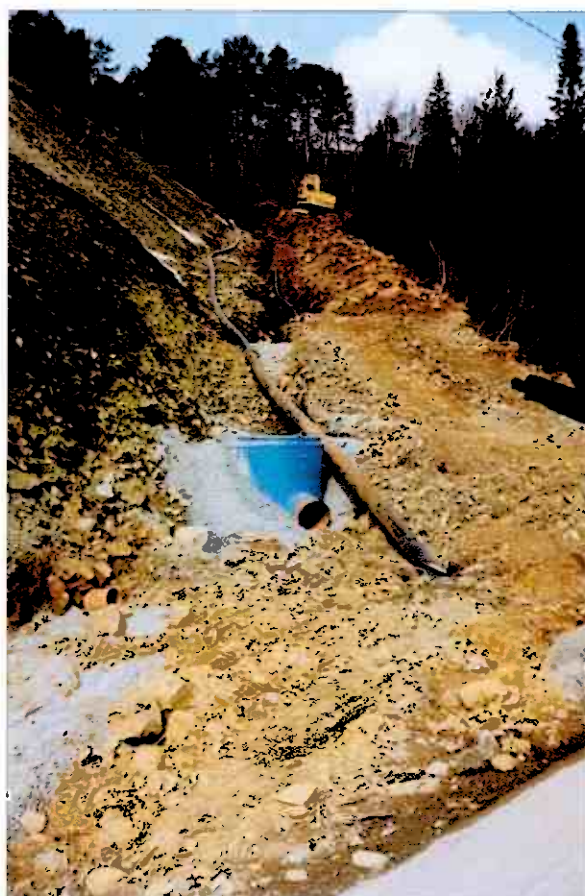
Groften fortsetter oppover mot grubeverkstedet og Gammelsjakt.
