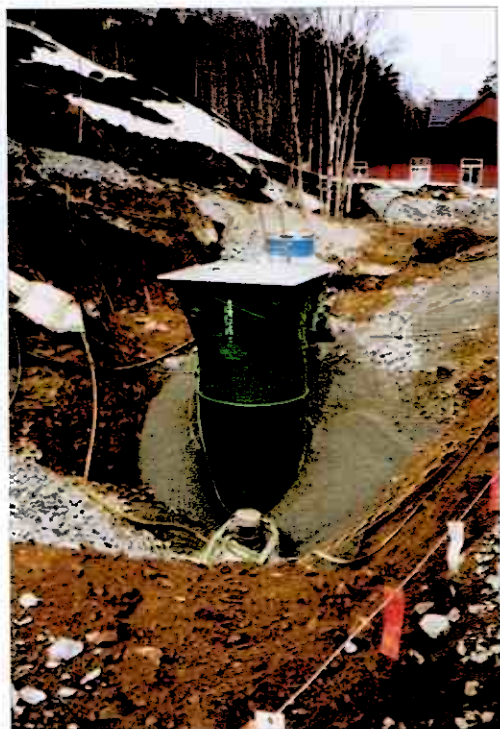
Til høyre: Tilbakefylling av graderte masser starter.
