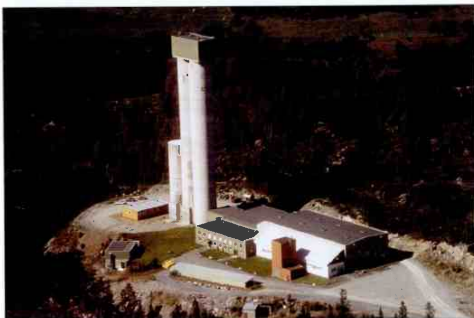
Norges Geologiske Undersøkelse har kjøpt driftsbygningene ved Astrup sjakt. Norwegian Ammunition Disposal Company AS driver sjaktanlegget.
