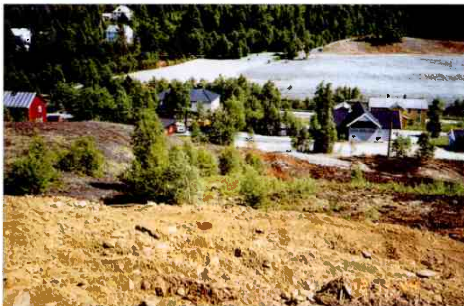
Bilde fra 1987. Alle opprednings- forsøk skrinlagt, og dammen gjevnet ut og dekket med 30 - 50 cm gråberg.
