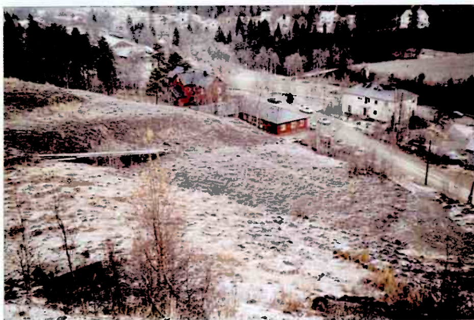
Bilde fra 1986. Tildekking av kobber- og sinkhydrat fra grubevannrensing.
