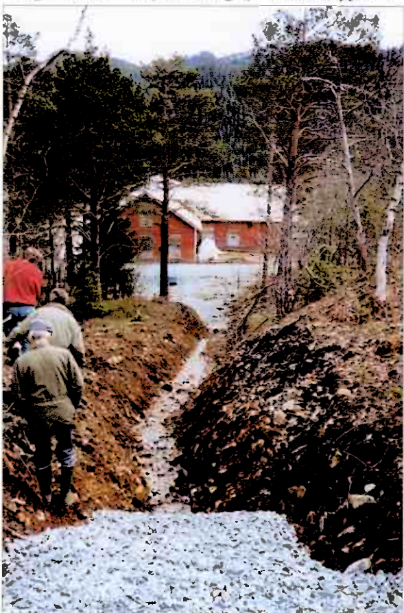
Fra grubeverkstedet fortsetter groften videre oppover.
