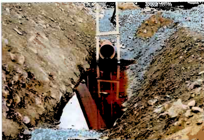
Over: Her skal plasseres en ny plastkum for adgang til transportrør.
