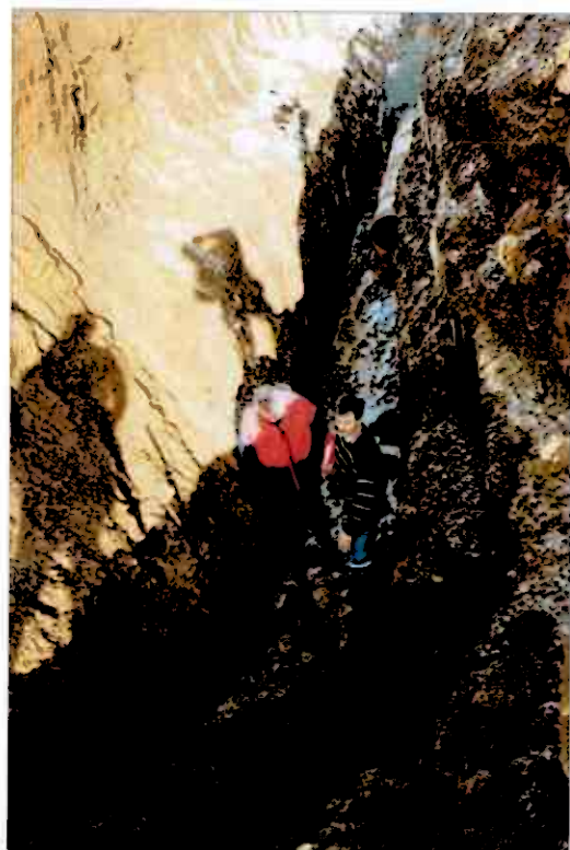
Under: Groften er 7 m dyp og tre rør legges, et større transportrør og to mindre drenerør.
