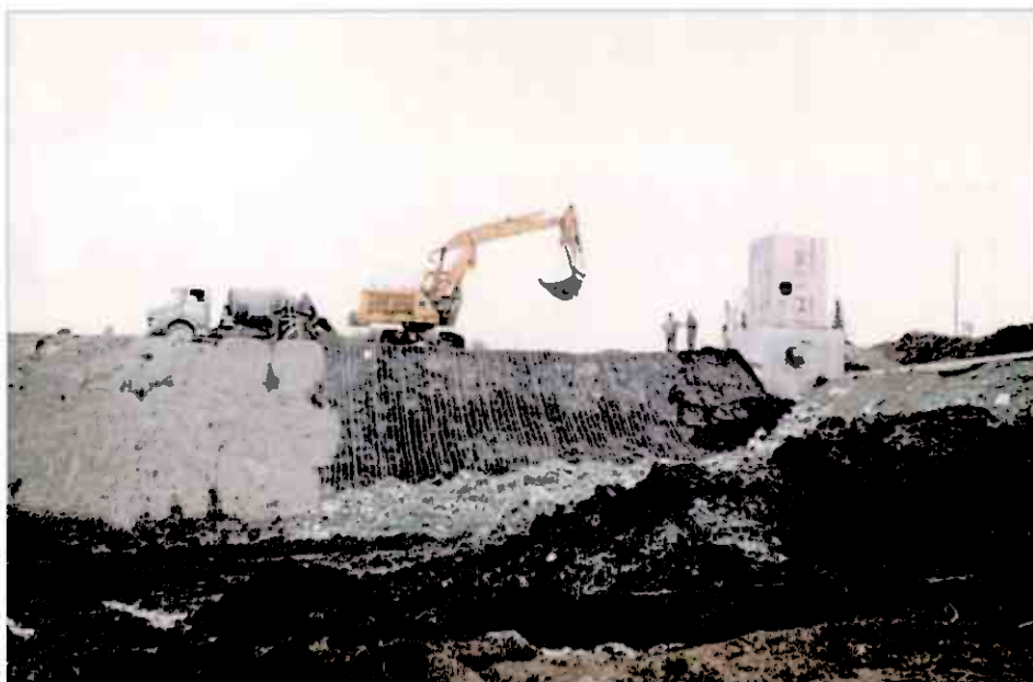
Bilde fra 1973. Bygging av hoveddammen med membrantetting og overløpstårn.
