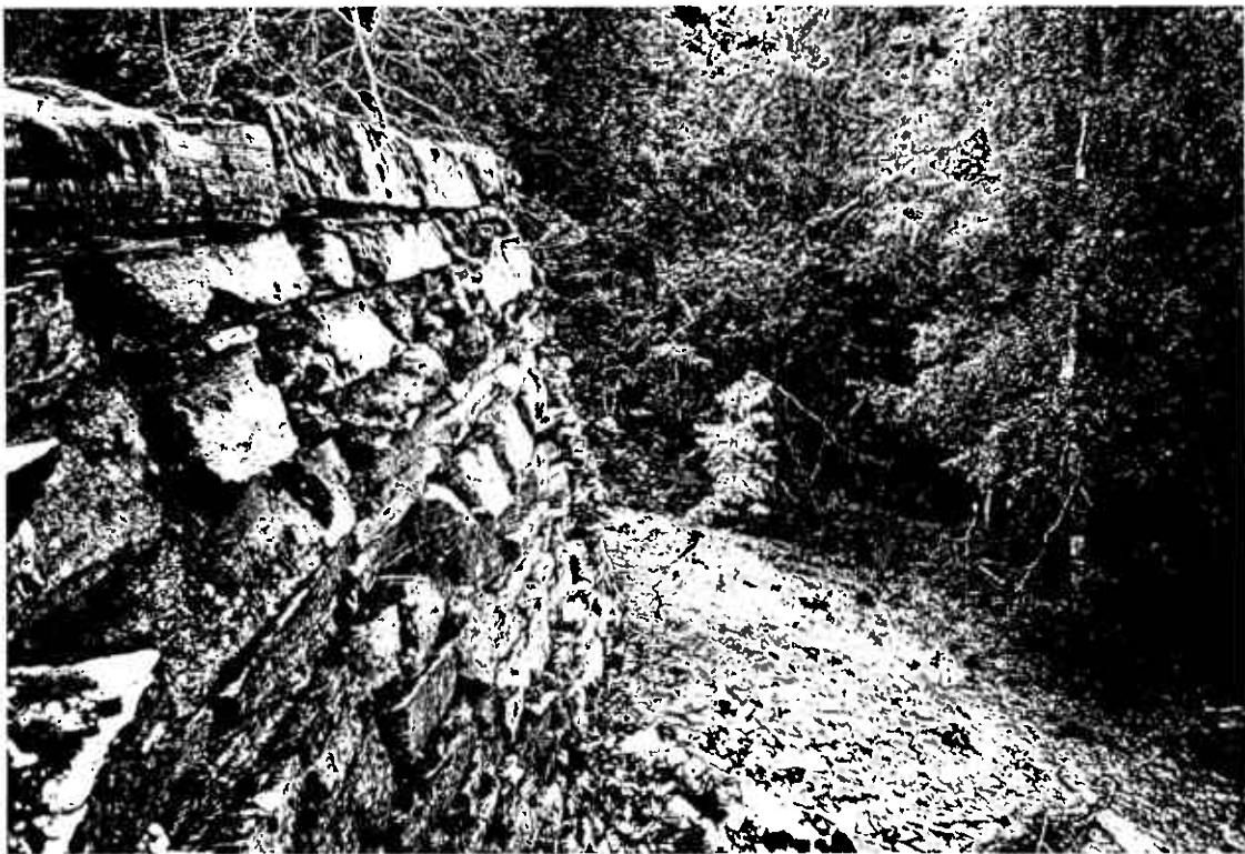
Figur 4-2 Oppbygget plattform for taubanen som skiferen ble fraktet ned med fra bruddet.
