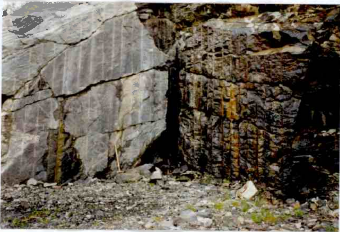
Fig. 7 "Benket" oppsprekking i Prøvebrudd Sørdal
