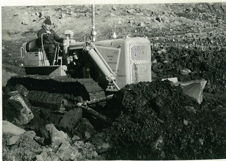
Caterpillar D-6 til kamp mot overdekning..
