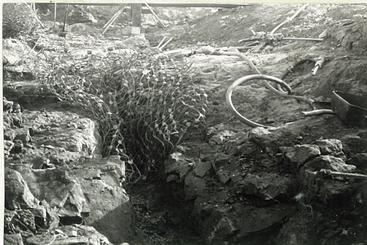
Klart for skyting av røskeprøve .
