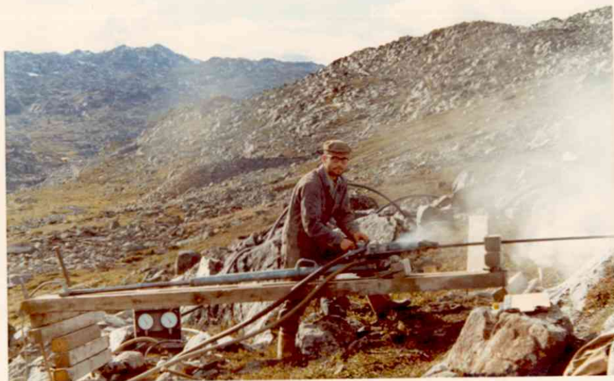
Vanlig oppetilling av borutstyret
