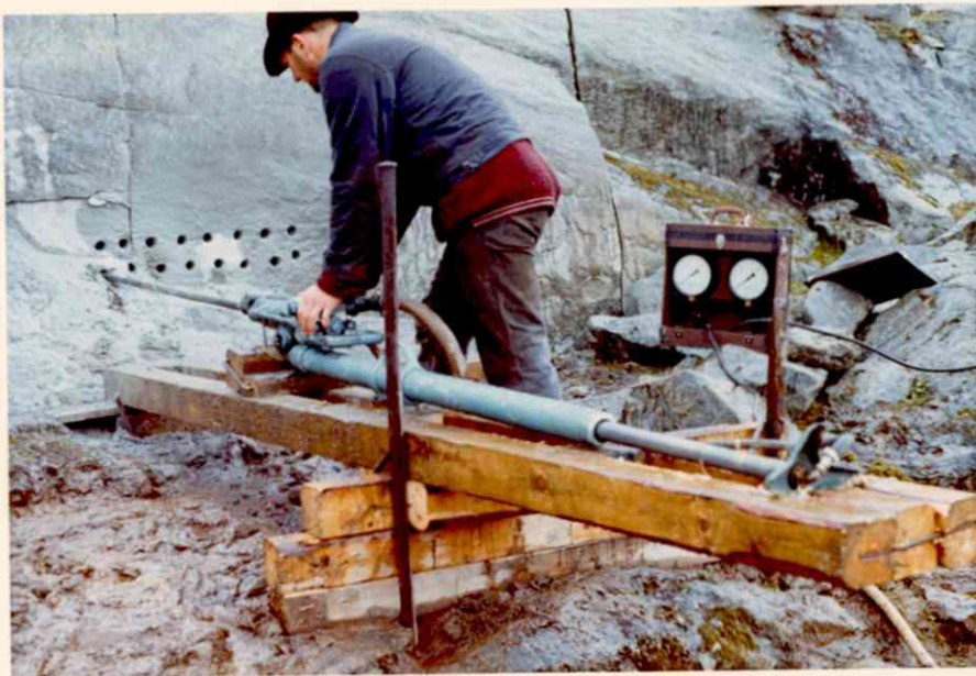
Oppstilling ved sterkt skrånende terreng.
