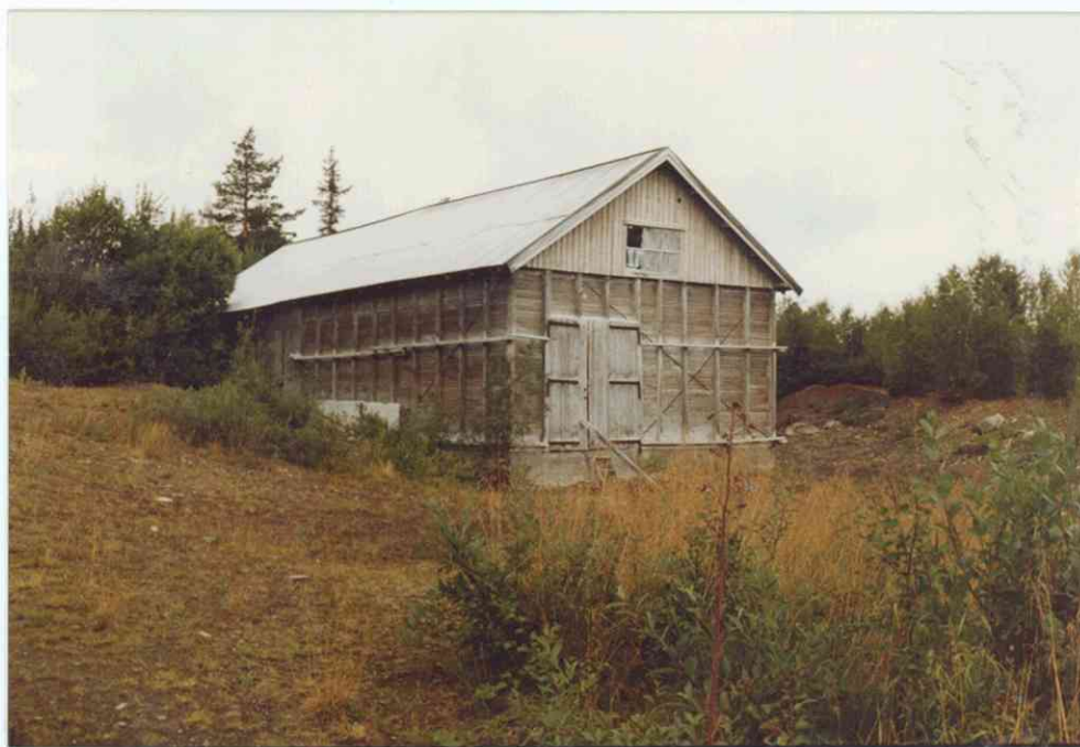
Foto 3. 1/9-82 Bilde av hus for knuseanlegg.
