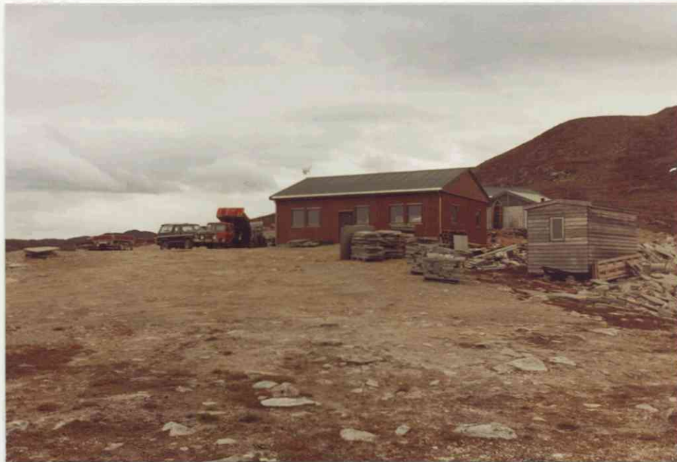
Foto 1. 23/9-81 Produksjonshall og lagerplass. På mønet av taket er montert en vindgenerator.
