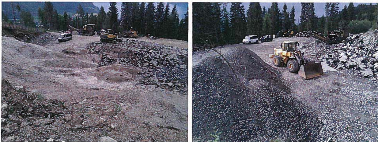
Foto: Juni og juli 2014. Bileta viser etablering område A, iht prøveuttak, i etappe 1 (tegn TB-110).
