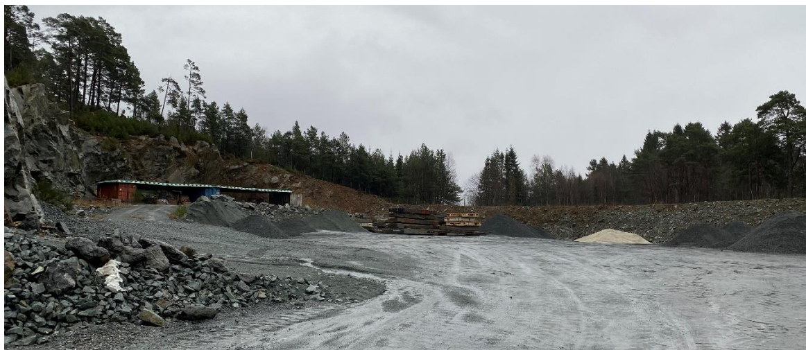
Figur 6: Sørøstre del av bruddet, med etablert skjermingsvoll mot Stongavegen.
