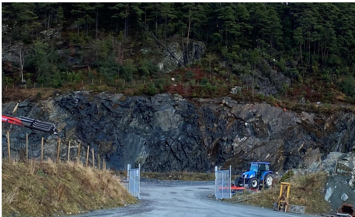
Figur 4: Foto av eksisterende bruddvegg.
