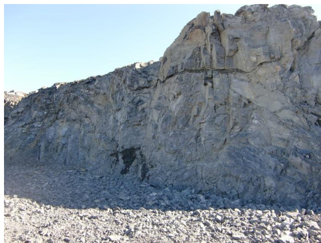
Fig. 5. Bildet viser eksempel på sprekkdannelser.
