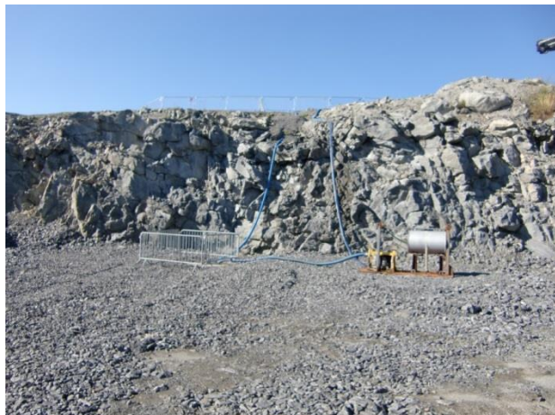
Fig. 9. Bildet til venstre viser plassering av pumpekum (inngjerdet) og pumpe. Over bruddkanten ses gjerder rundt sedimenteringsbassenget
