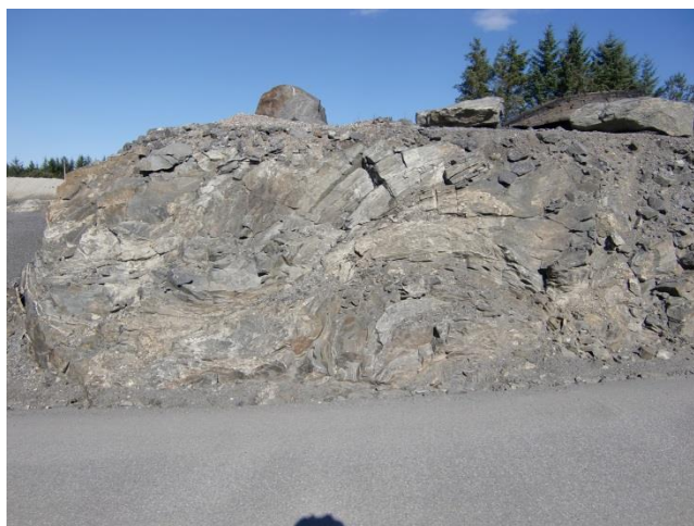
Fig. 4. Bildet viser eksempel på sprekkdannelser.
