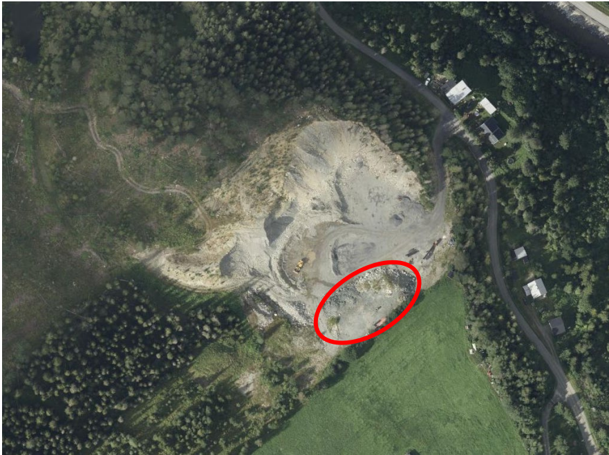
Utklipp av ortofoto fra Norgebilder.no med markering av sprengsteinshaug.
