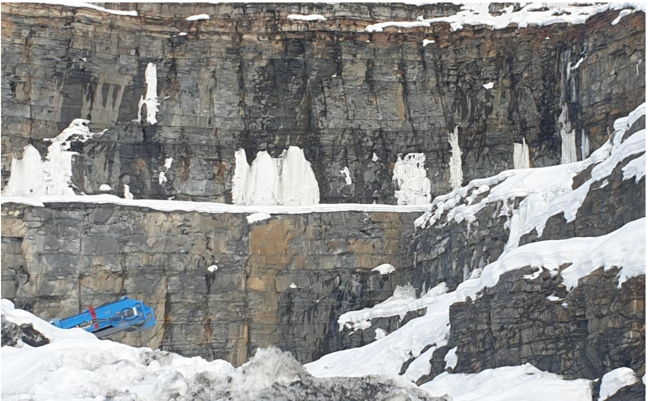
Figur 4 Foto av bruddveggen 04.03.21 der vi tydelig ser borpipene i pallfront
