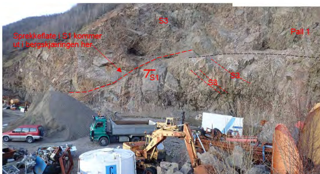
Bilde 9. Nedre nivå. Sammensatt bilde. Markert gjennomgående sprekk langs sprekkesett 1.
