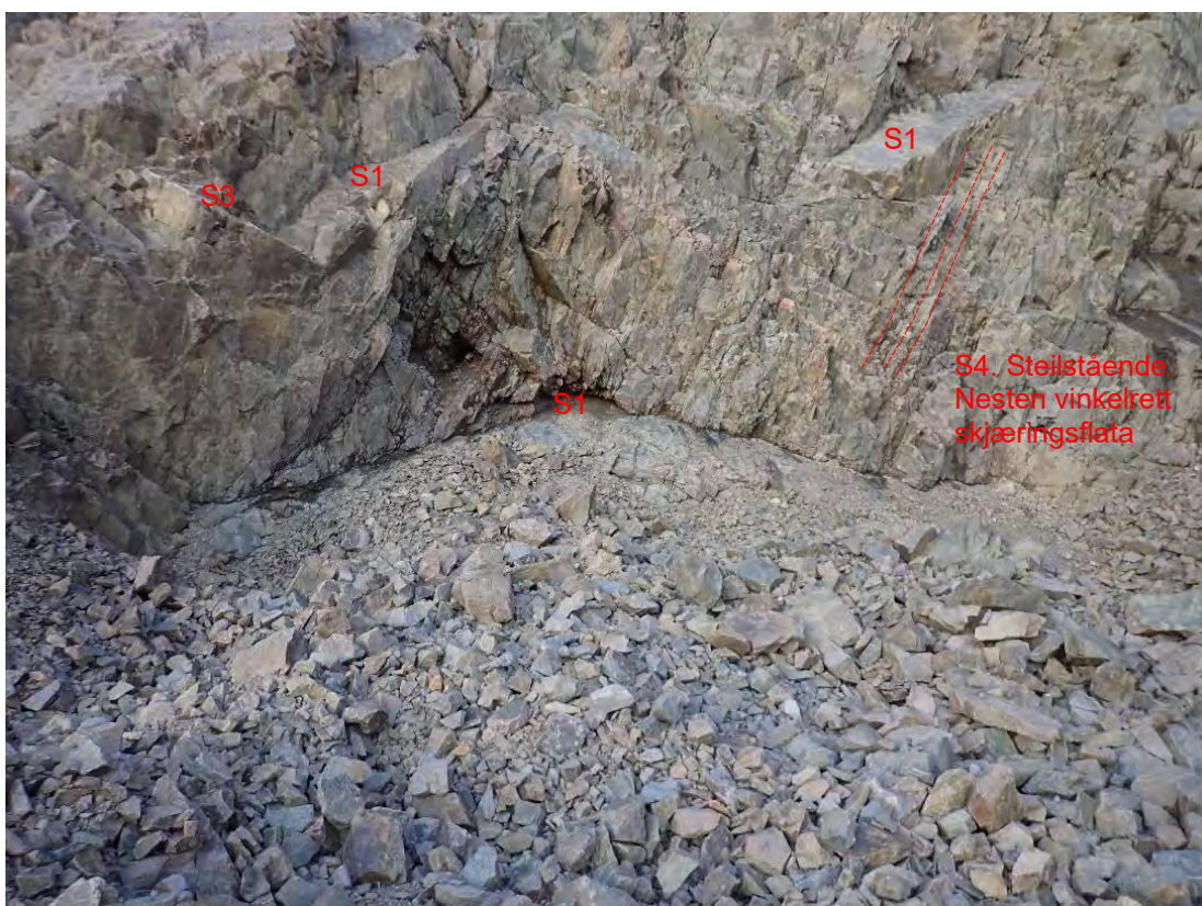
Figur 6. Bergskjæring mellom pall 1 og 2. Tatt mot nordvest. Sprekkesettene er markert.
