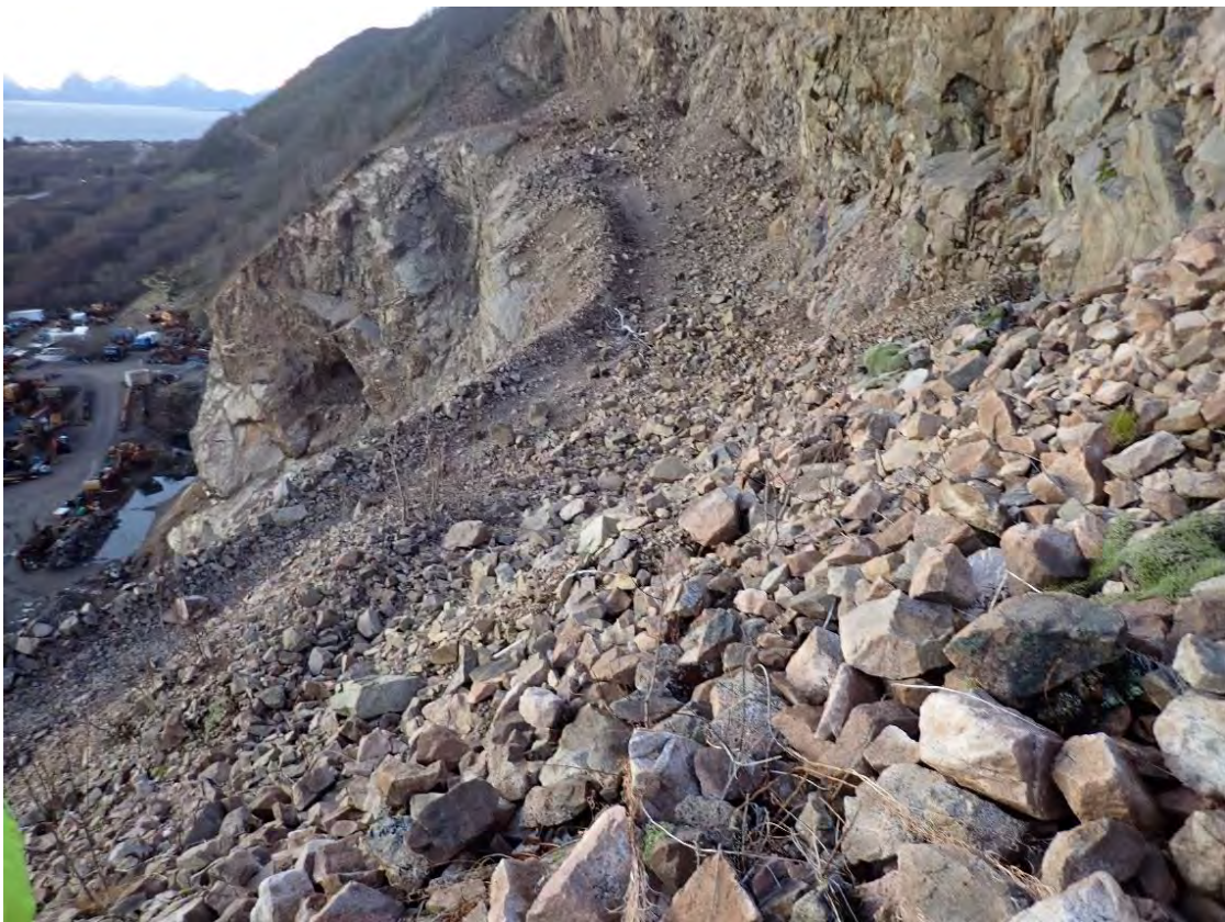
Bilde 4. Øverste eksisterende pall 2, ca kote 70.
