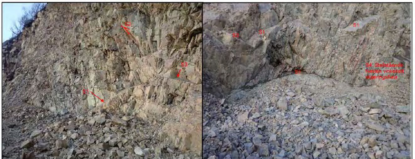
Figur 6: Eksempler på hvordan sprekkeseettene er synlig i bruddet.
