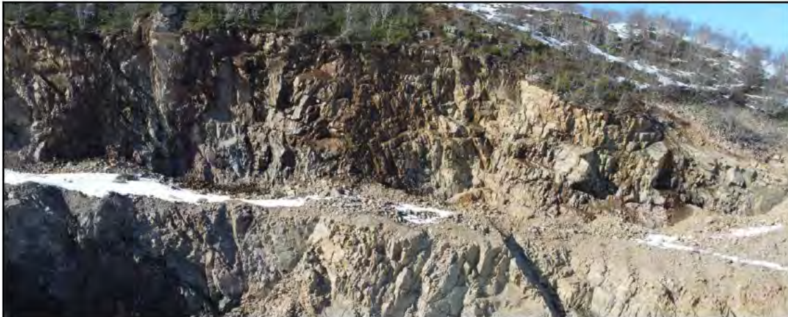
Figur 9 Oppsprukket bergmasse med relativt lav GSI i øverste pall
