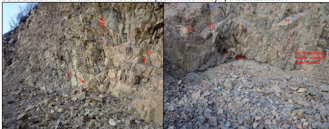
Figur 4: Eksempler på hvordan sprekkesettene er synlig i bruddet.
