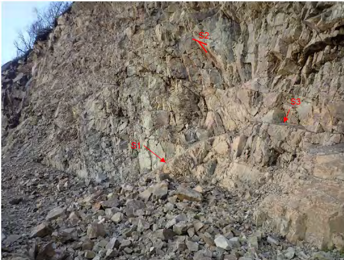
Figur 7. Bergskjæring ovenfor eksisterende pall 2. Tatt mot vest.
