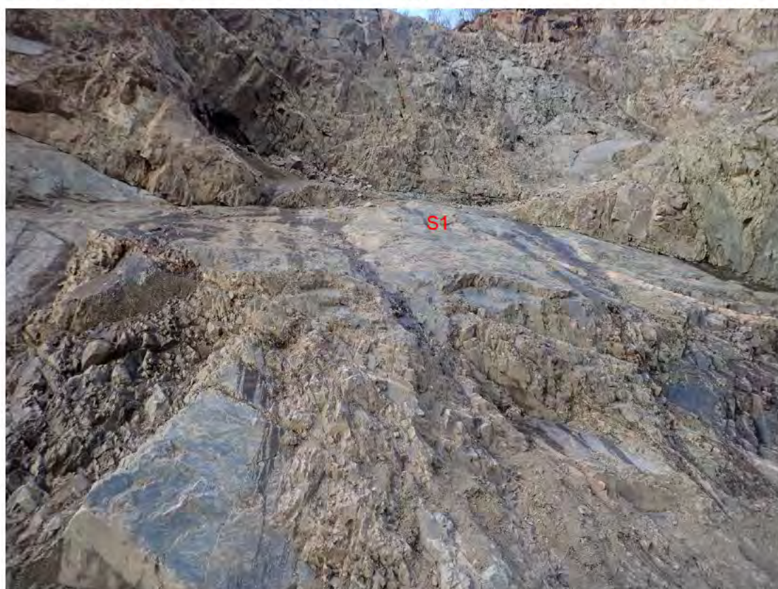
Bilde 10. Nærbilde av sprekkeplan S1. Markert, gjennomgående sprekk. Ru overflate. Partier med nokså oppknust berg angitt.
