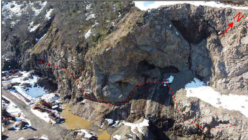
Figur 4 Markant utgående sprekk med tilsvarende orientering som sprekkeseett 1 markert med rød stiplet linje og omriss.
