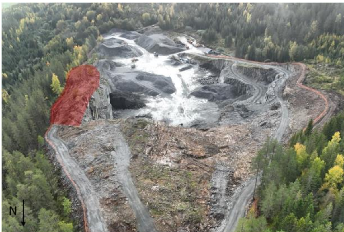
Figur 9: Dronefoto av pukkverket tatt mot sør. Til venstre i bilde er østpallen markert med rødt..
