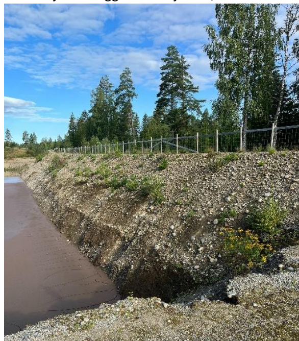
Figur 6 Slambasseng hvor overskuddsmassen fra vaskeprosessen blir samlet for naturlig avrenning.
