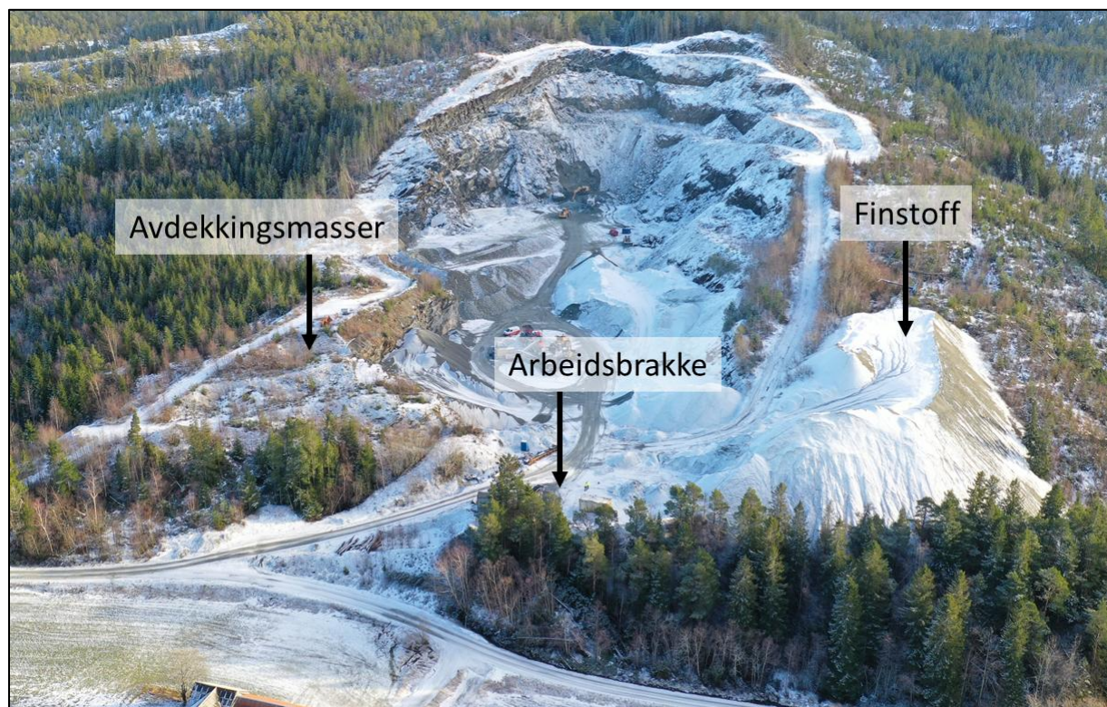
Figur 9 Dronebilde 19.02.2020 som viser hva som må ryddes ved avslutning.
