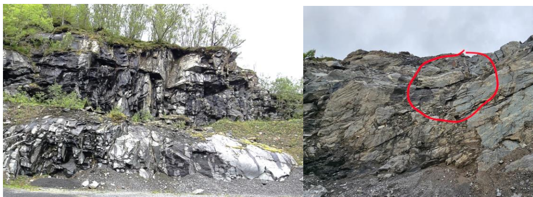
Figur 5: Bilde tatt mot øst. Typisk kiledannelse i N-S gående skjæring langs sett 1. bildet til venstre viser løs blokk i eks. skjæring.
