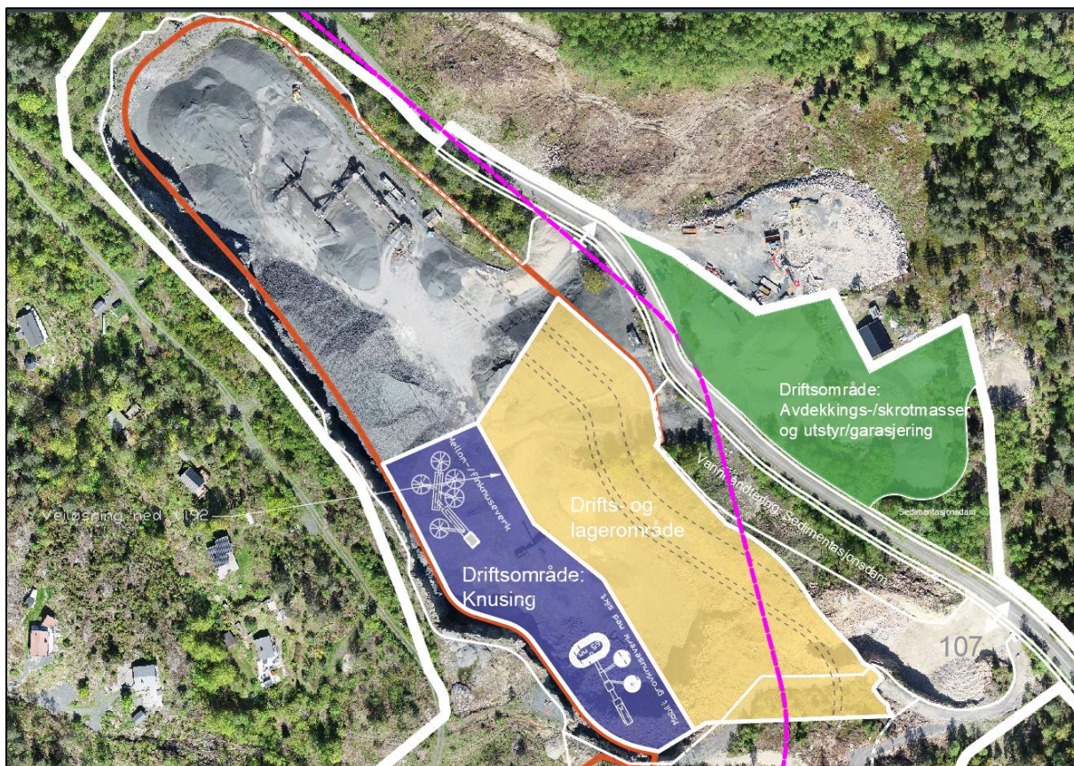
Figur 7-1: Eksisterende situasjon Hurum pukkverk. Stasjonært finknuse-/sikteverk lengst nord i bruddet er demontert/avviklet etter at bildet ble tatt i 2024.
