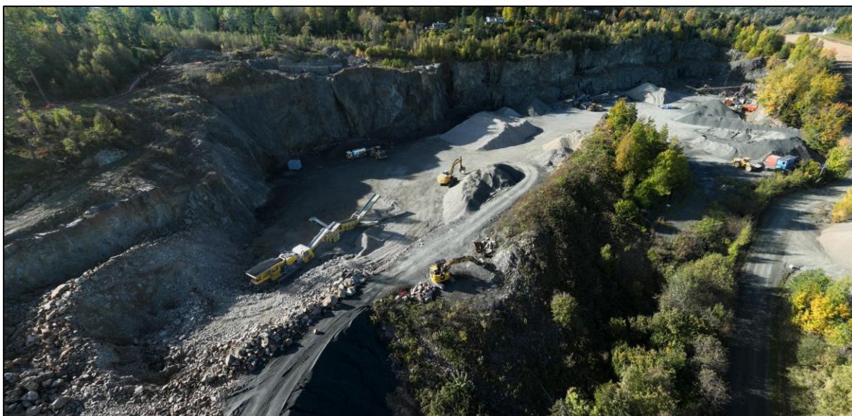
Figur 7-2: Skråfoto som viser dagens bruddområde, fra sørøst mot nordvest.
