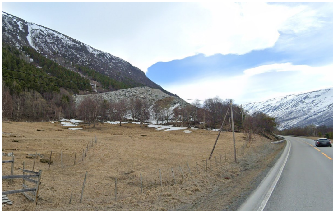
Figur 4: Bilde tatt fra E6 mot nordsiden av bruddet, som viser tipphaugen helt nord i bruddet og det bratte terrenget på oversiden av bruddet (Google street view, mai 2023).
