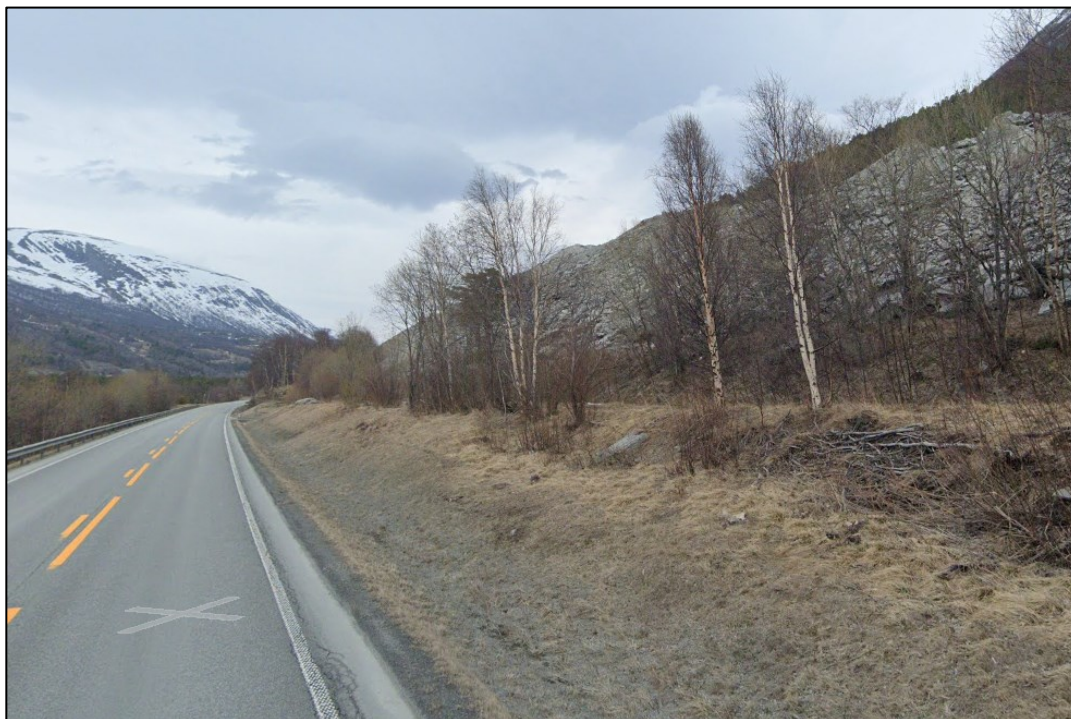
Figur 5: Bilde tatt fra E6 mot vestsiden av bruddet. Fyllingen ut mot E6 danner en naturlig sikringsvoll (Google street view, mai 2023).
