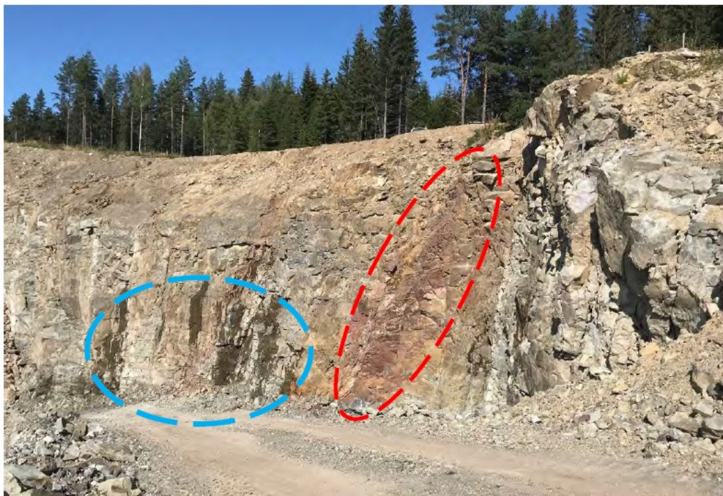
Figur 5 Bergskjæringer på toppen av hovedmassetaket er generelt oppsprukket med en registrert svakhetssone som faller 70° mot N218°Ø (merket i rød). Det er vannførende sprekker i skjæring (merket i blå).
