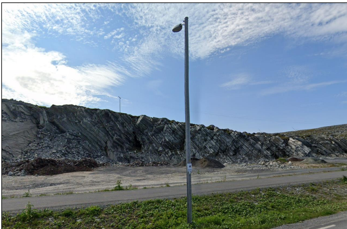
Figur 6 Bilde hentet fra Google Maps som viser hovedsprekkesettet/lagdelingen til bergmassen i området.
