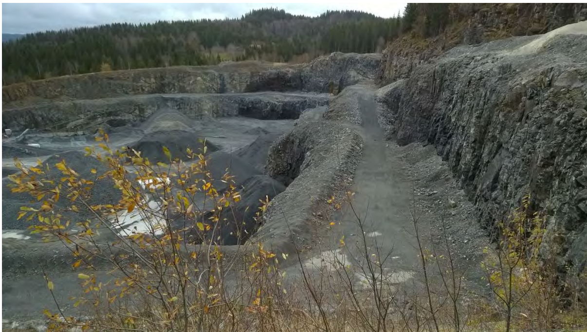
Figur 7: Pallehyller sikret med voll langs kanten.
