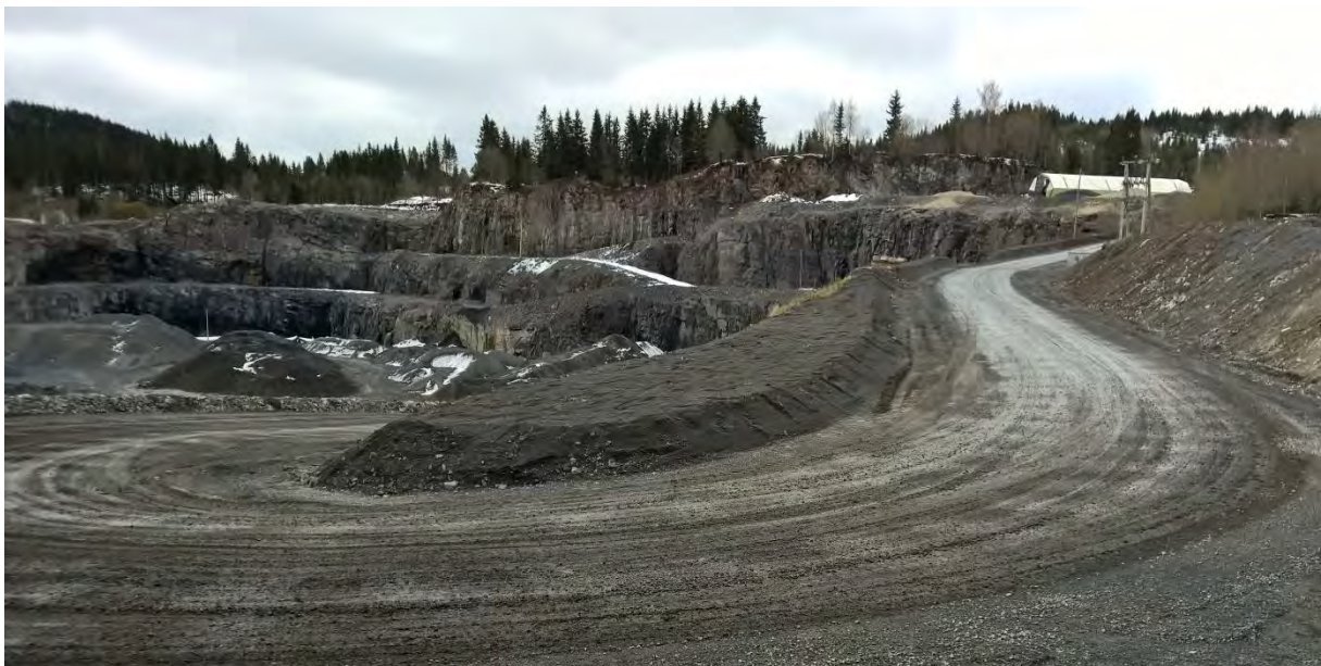
Figur 6: Adkomstveg ned i bruddet er sikret med voll.
